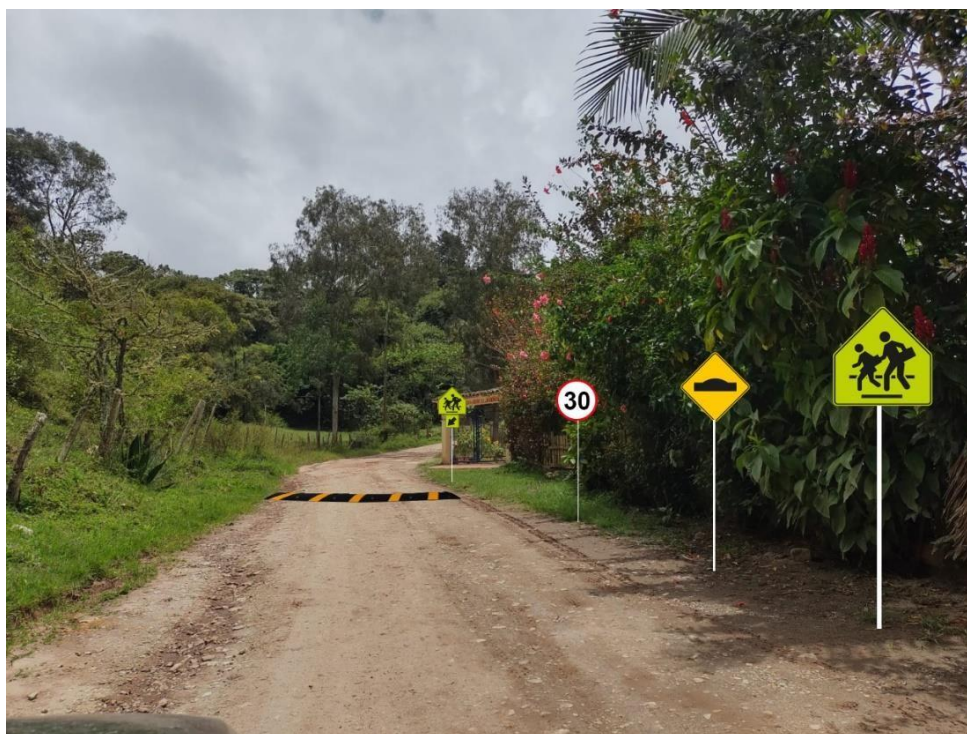
Figura 28. Tramo Vial con señalización Zona Escolar “Sede el Jaboncillo “
