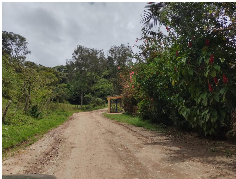
Figura 27. Tramo Vial sin señalización Zona Escolar “Sede el Jaboncillo “
