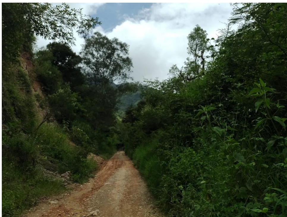
Figura 17. Presencia de desprendimiento de taludes.
