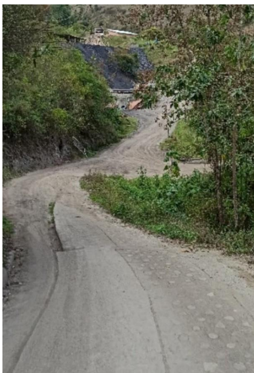
Figura 23. Tramo Vial sin señalización (entrada a zona de Minería)
