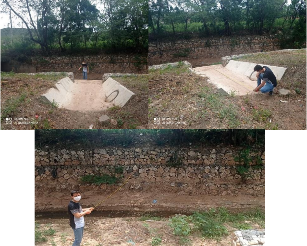
Canal de evacuación ubicada en la calle 35 con avenida 4E
