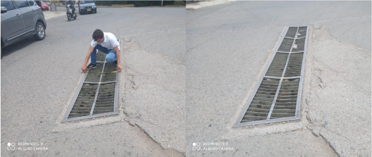
Rejilla de evacuación ubicada en la calle 25 con avenida 5E
