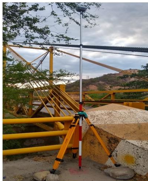
Fotografía 11. Instalación del equipo
