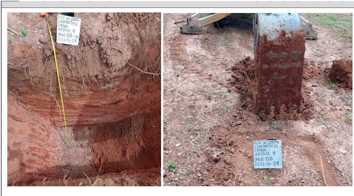
Figura 18. Imágenes ejecución de apique #5
