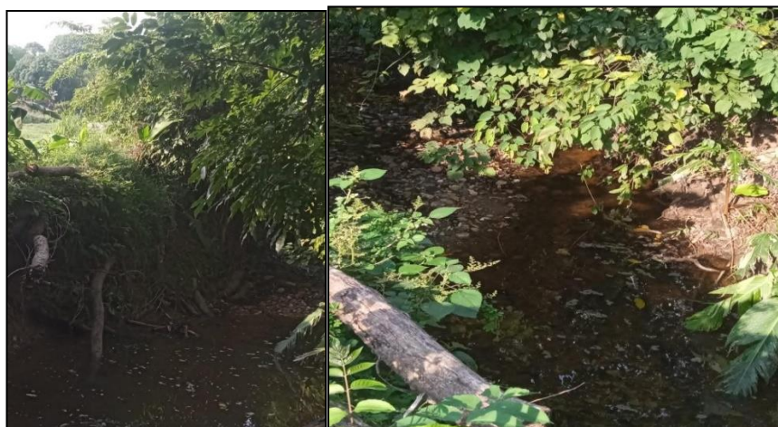
Figura 14. Lugar de disposición final de aguas residuales.
