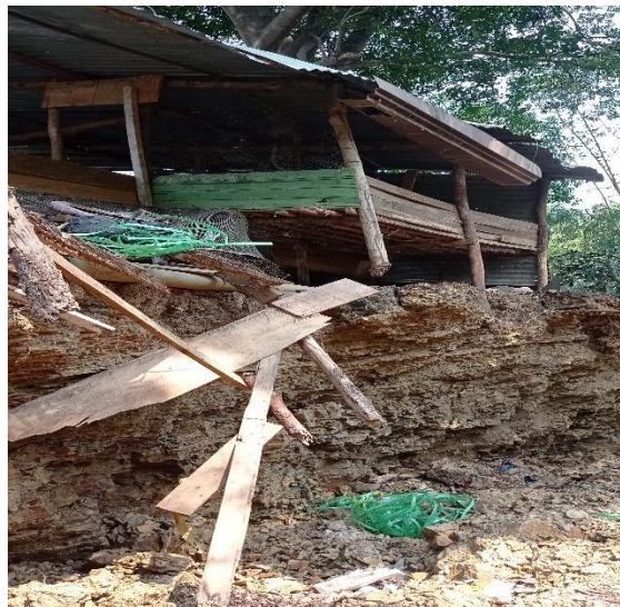
Figura 17. Localización del proyecto, sector la Ermita, A3 zona afectada Cúcuta, Colombia
