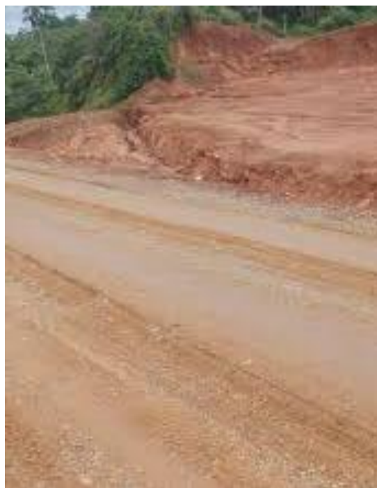
Figura 11. Capa de Rodadura en Afirmado.
