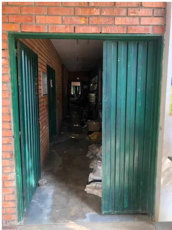
Figura 19. Acceso al laboratorio
