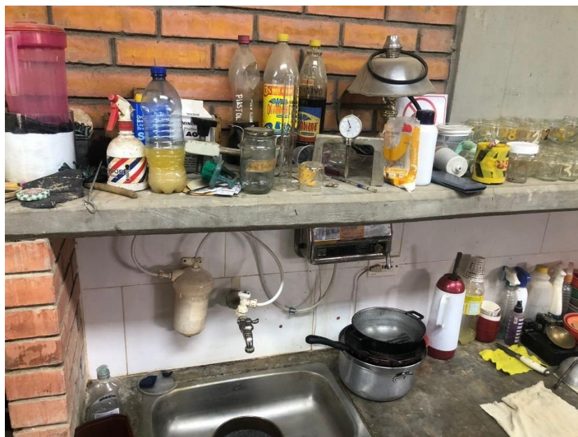
Figura 24. Estado actual mesones
