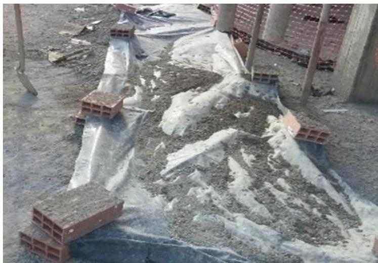
**Figura 40.** Plástico en el piso con el fin de que no se adhiera a este.
