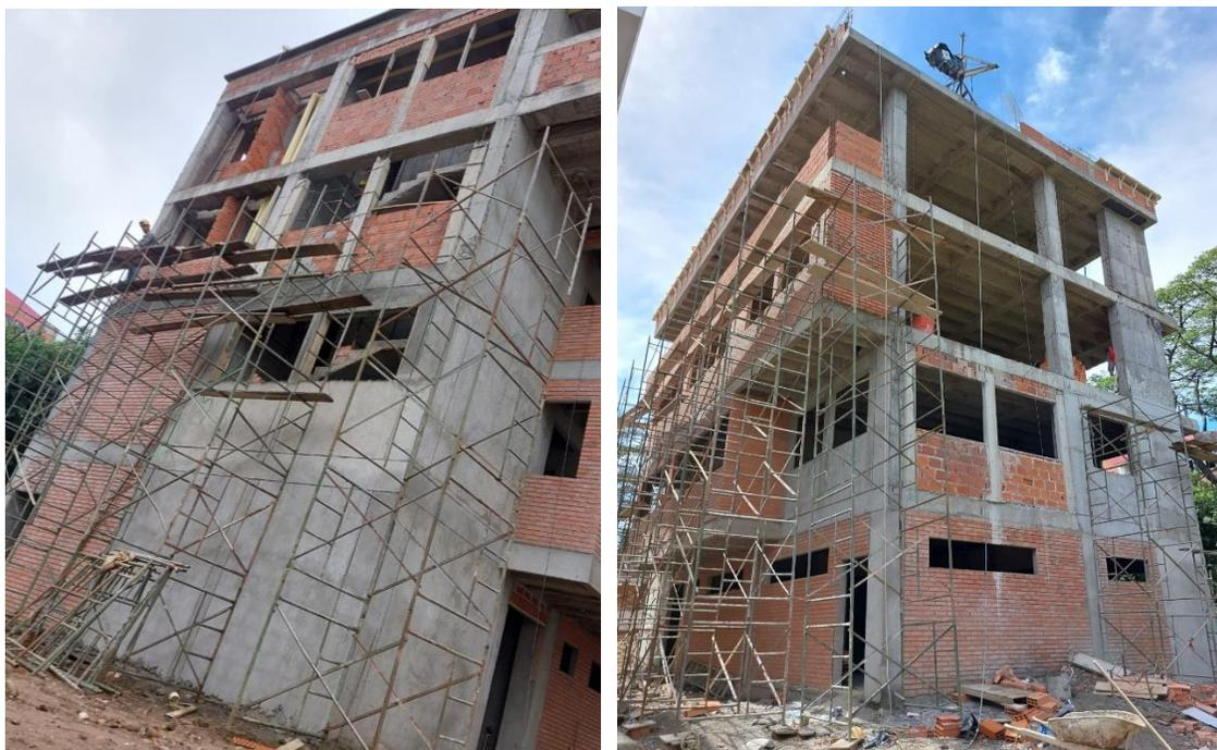
**Figura 77.** Acomodo de zona (armado y desarmado de andamios)
