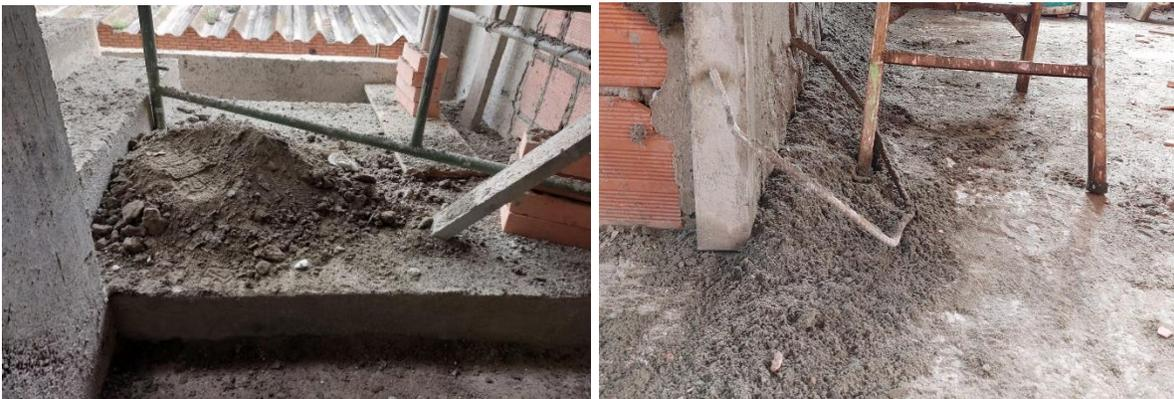
**Figura 36.** Desperdicio de mortero que no se utiliza al caer al suelo en pañete interior
