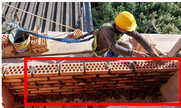
**Figura 33.** Desperdicio en ejecución de muro en ladrillo a la vista
