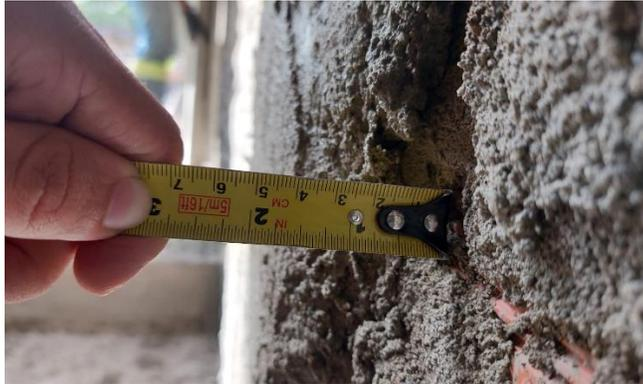
**Figura 35.** Desperdicio por espesor de pañete
