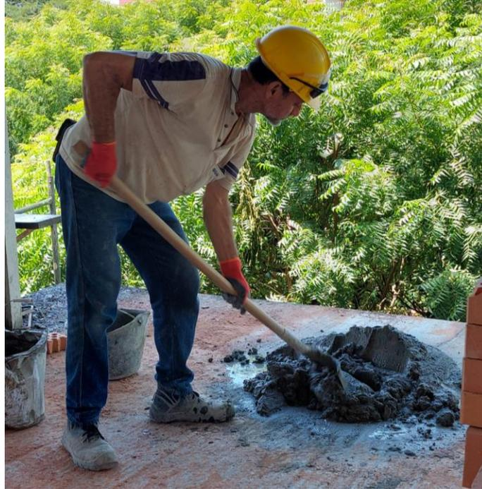
**Figura 64.** Preparación de mortero.
