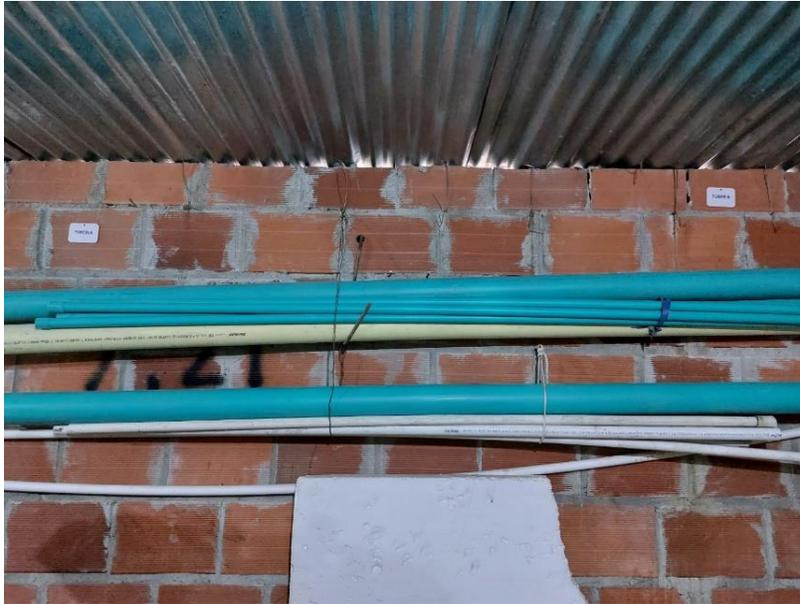
**Figura 102.** Etiquetado para tubería de hidráulica y eléctrica.
