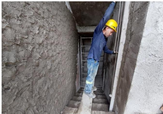
**Figura 65.** Toma de nivel vertical con plomada
