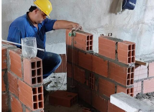
**Figura 43.** Toma de nivel con plomada vertical
