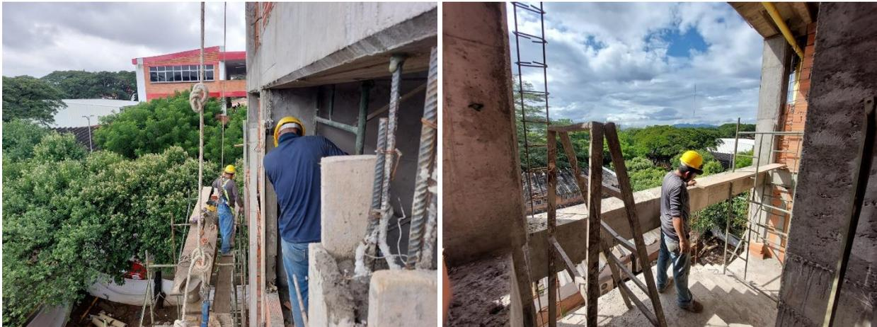
**Figura 50.** Acomodo de la zona (armado y desarmado de andamios en interiores y exteriores)
