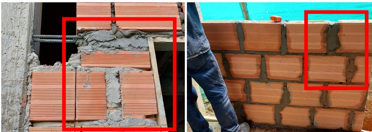
**Figura 32.** Desperdicio en juntas de separación de muro en bloque N°5
