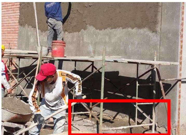
**Figura 37.** Desperdicio de mortero que no se utiliza al caer al suelo en pañete exterior
