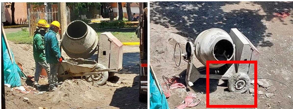
**Figura 34.** Desperdicio por sobrellenado de mortero en la carretilla
