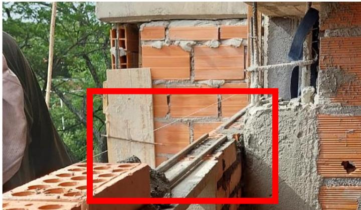
*Figura 46.* Instalación de anclaje en ladrillo a la vista.
