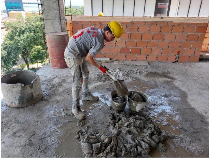
*Figura 45.* Preparación de mortero
