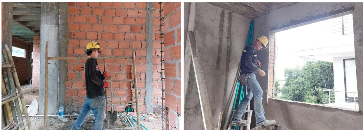
**Figura 67.** Acomodo de la zona (transporte de andamio e instalación de codales)
