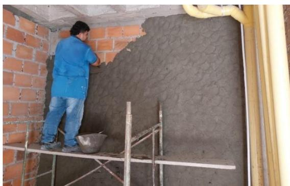
*Figura 62.* Aplicación de mortero.
