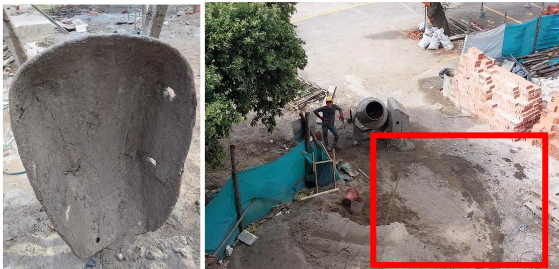
**Figura 38.** Desperdicio de mortero en transporte debido a carretillas rotas.
