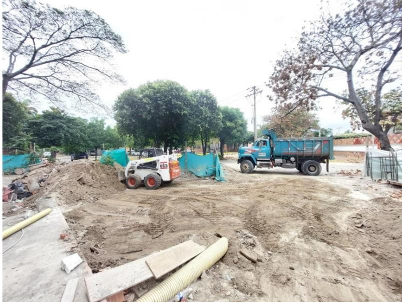
**Figura 107.** Limpieza a exterior de la construcción y retiro a escombrera.
