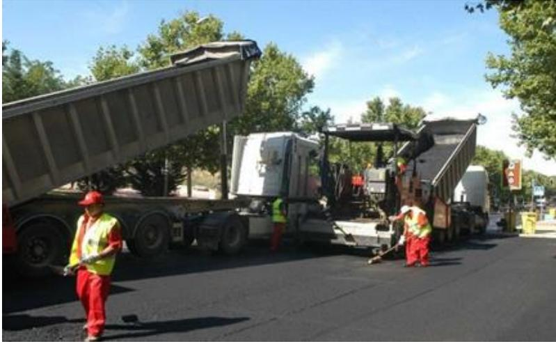
**Figura 1.** Mezcla asfáltica densa en caliente.
