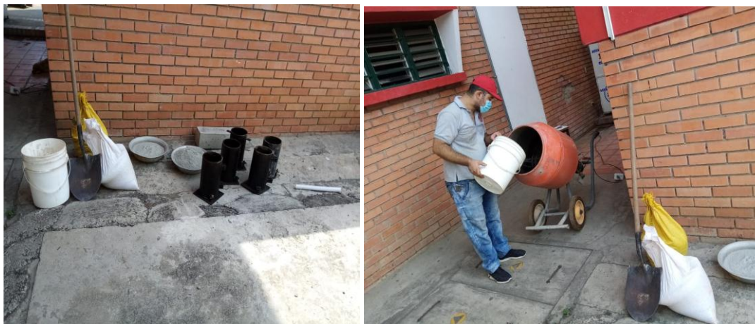
Figura 11. Dosificación lista para llevarla a la mezcladora
