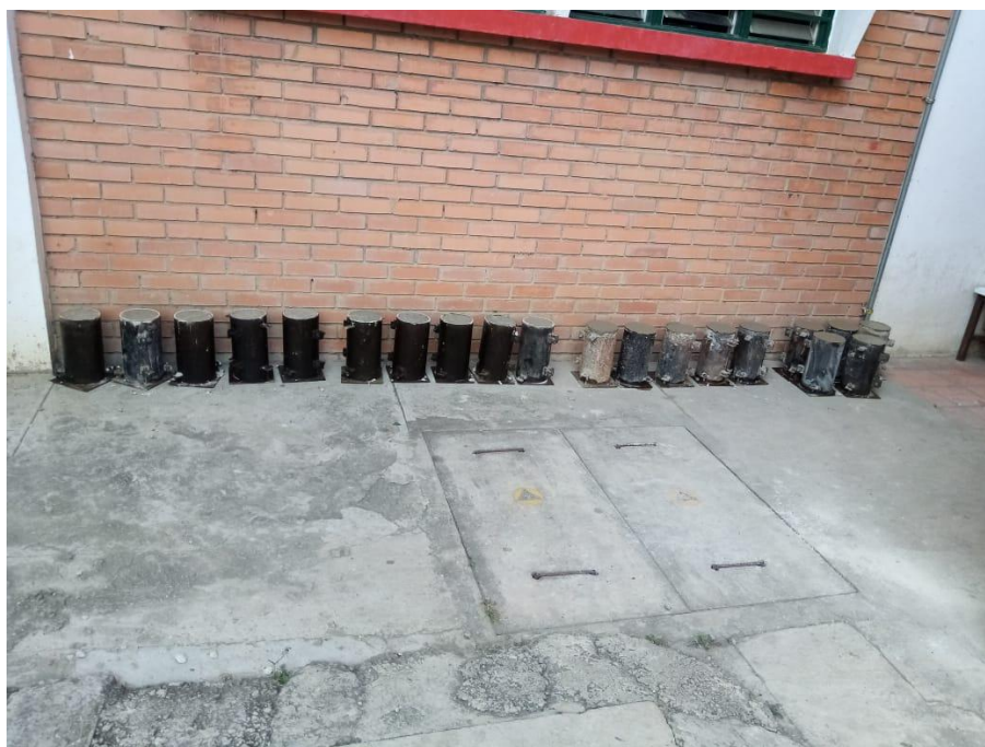
Figura 14. Finalización del vaciado de los cilindros a ensayar, con las diferentes mezclas de agregado fino de la planta trans materiales y concreto triturado
