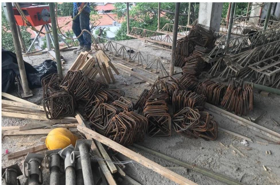
**Figura 20. Actividad importante de la semana – figurado y armado de acero 2do piso**
