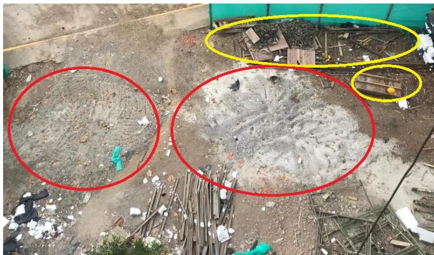
**Figura 10. Desperdicio de concreto y tableros**
