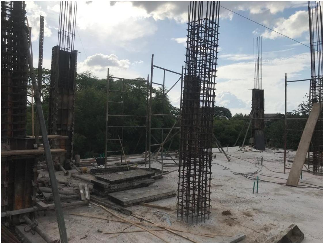
**Figura 27. Actividad importante de la semana - armado de acero de refuerzo de columnas
