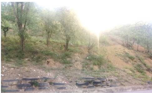
Figura 24. Vista general del talud N°6
