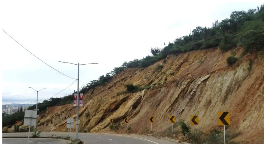
Figura 72. Vista parcial de la geometría o morfología del talud - tramo 5
