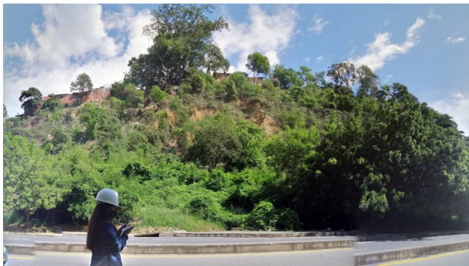
Figura 17. Vista general del talud N°1
