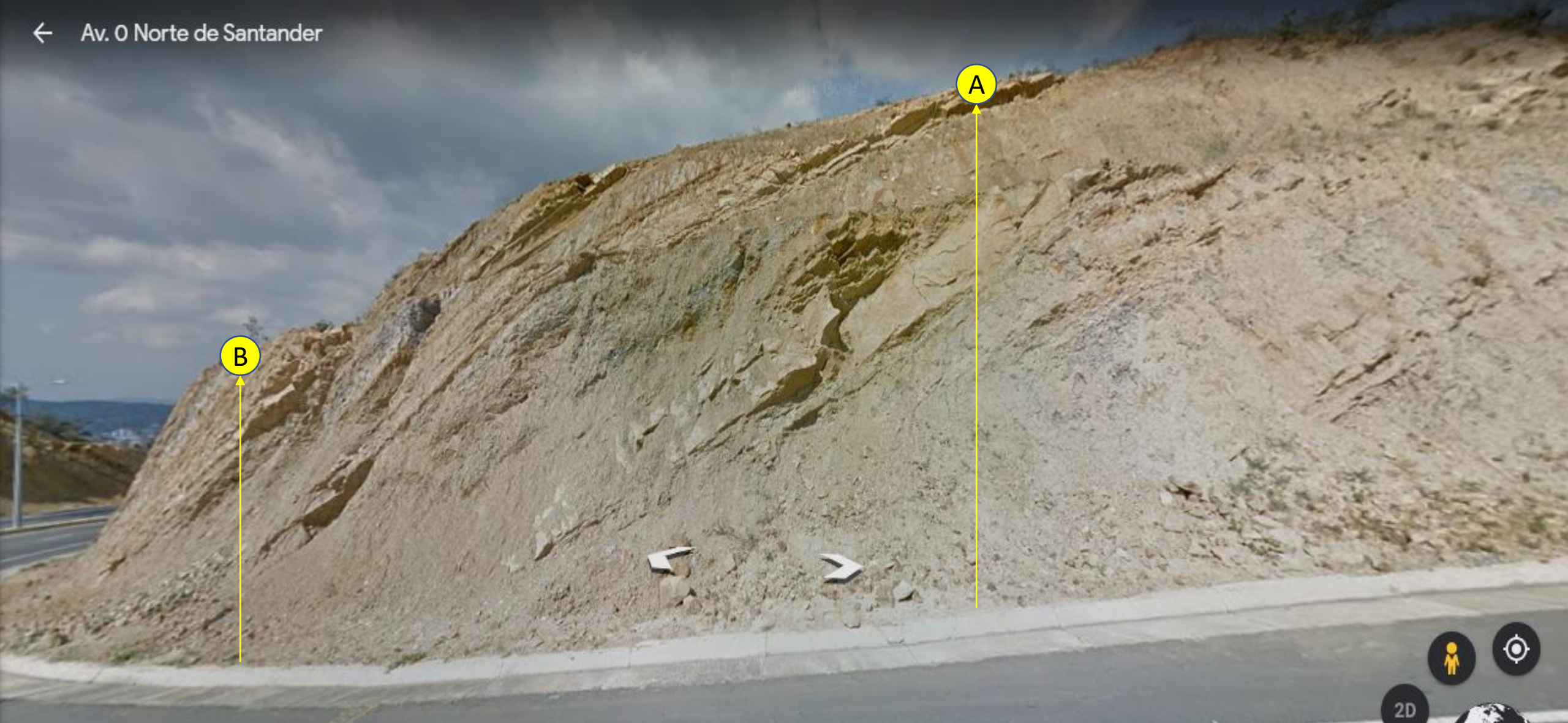
Alternancia de capas de espesor variable, inclinadas, de arenisca fina y limolitas, altamente fracturadas, de color pardo claro con arcillolitas abigarradas, meteorizadas. Huellas en surco de erosión hídrica. Pérdida de geomaterial de soporte bajo algunos estratos de arenisca; esporádicos desprendimientos en cuña de bloques líticos, Meteorización diferencial. Desprendimiento de bloques, acumulación de sedimentos al pie del talud. Talud balconado artificialmente. Álvaro Pedroza R – Mayo 2021.
