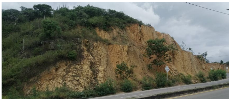
Figura 64. Vista parcial tramo 3
