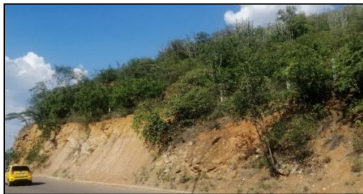
Figura 22. Vista general del talud N°4
