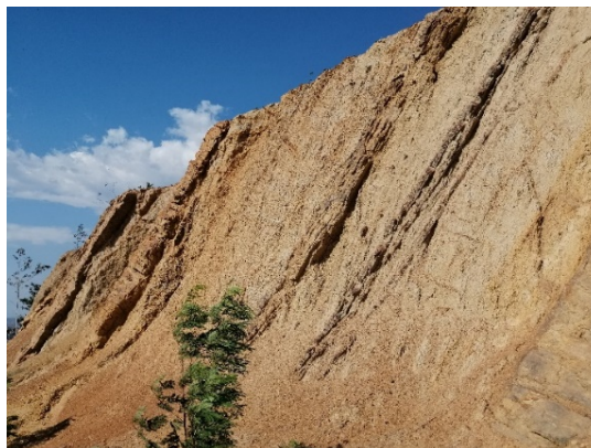
Figura 20. Vista general del talud N°3
