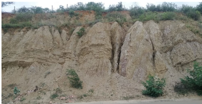
Figura 59. Vista parcial tramo 1
