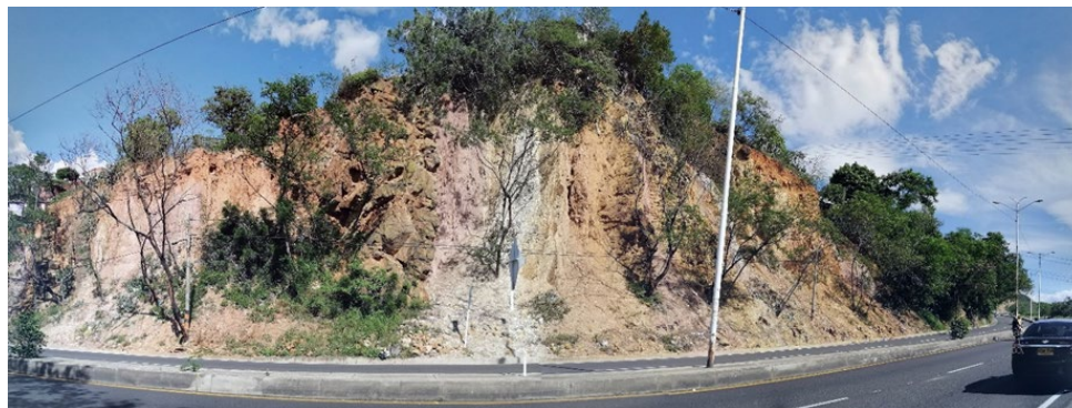
Figura 18. Vista general de la primera parte del talud N°2 ubicado en la autopista internacional
