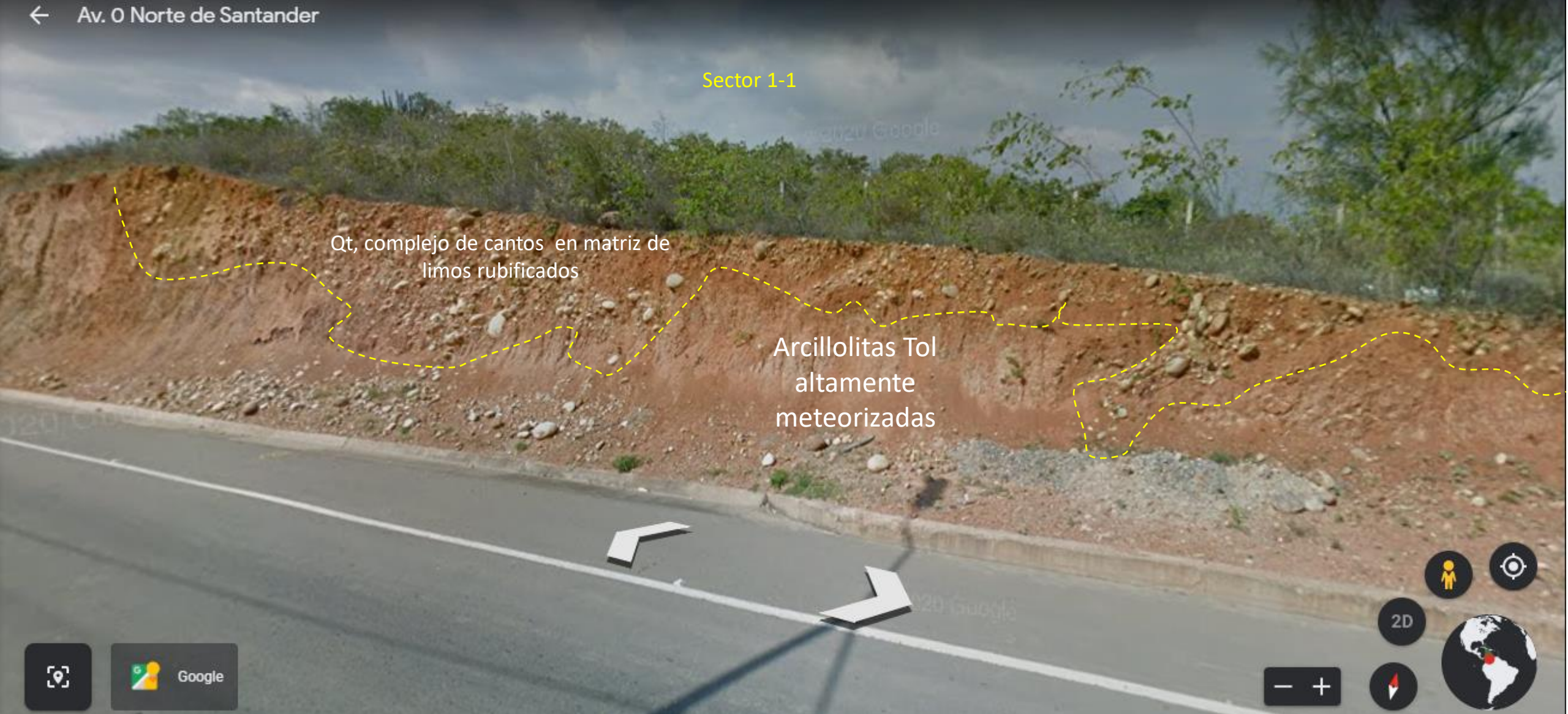
Fotografía Sector 1-1 del Subtramo 1-2. El complejo de cantos y limos rubificados cuaternarios descansa sobre arcillolitas y limolitas rojizas terciarias. El plano de contacto entre las dos formaciones es disconforme y revela procesos de erosión previa al proceso de depositación de los conglomerados. Depósitos de talus al pie del talud; los talus están conformados por acumulación de clastos individuales, dispuestos en el pie de los taludes y laderas, desprendidos por caída, durante las épocas invernales, de las capas superiores de geomaterial clástico. Alvaro Pedroza Rojas, abril 2021.
