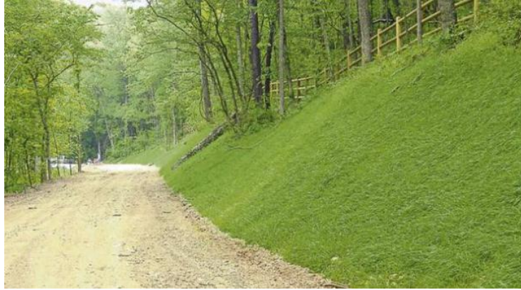
Figura 15. Cobertura vegetal de un talud Fuente: https://www.elcomercio.com/ 1
