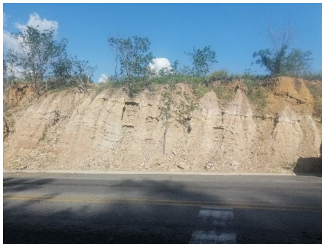
Figura 25. Vista general del talud N°7
