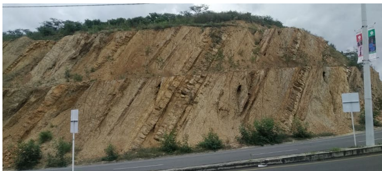
Figura 62. Vista parcial tramo 2
