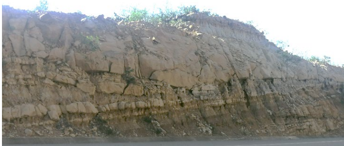
Figura 27. Vista general del talud N°8
