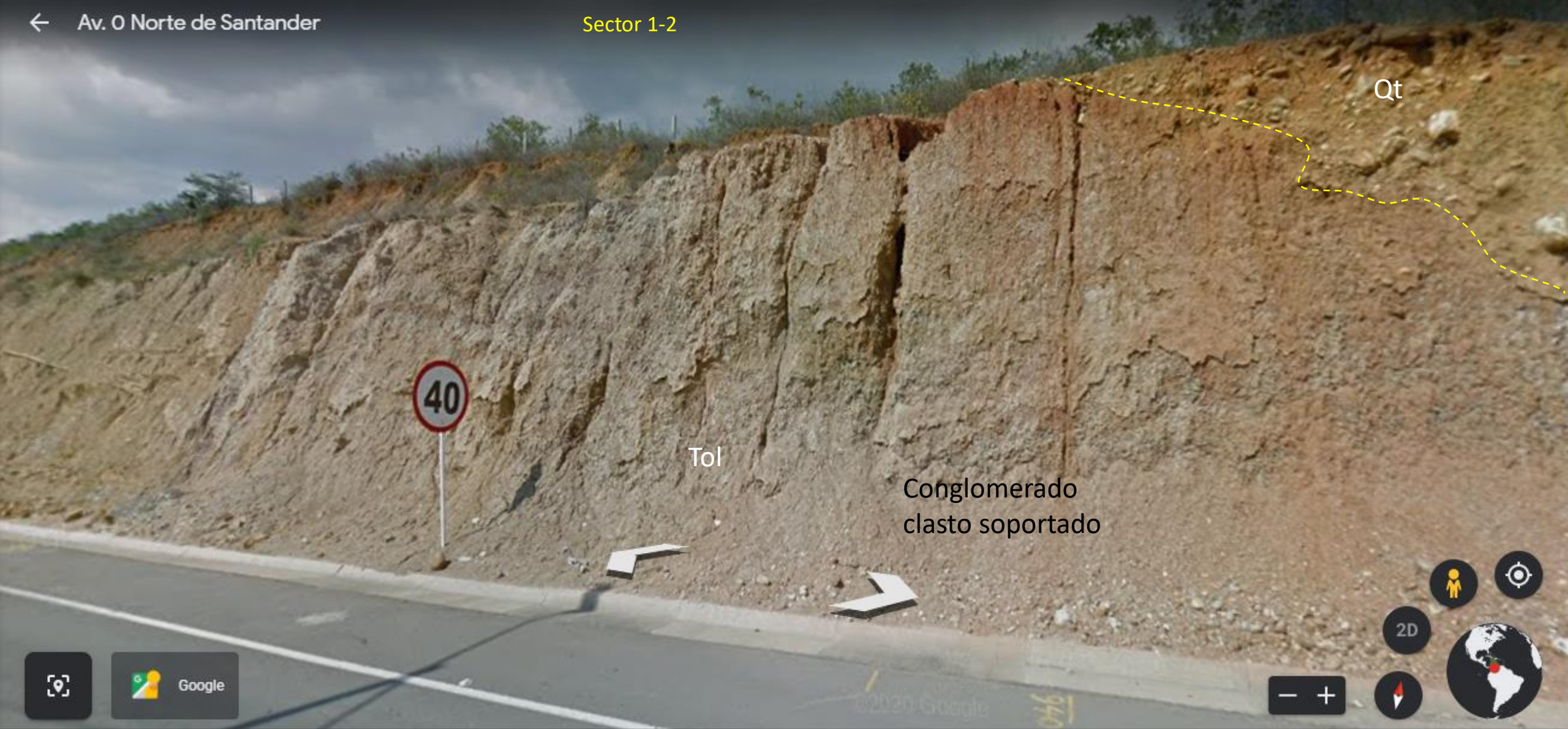
Fotografía Sector 1-2 del Tramo 1-2. Talud casi vertical conformado por geomaterial predominantemente limoso, con corona plana a semiplana, natural y artificialmente conformada, lo cual favoreció los procesos erosivos hídricos especialmente la formación de cárcavamientos y el desarrollo de tubificación (erosión interna). La superficie del talud muestra rasgos de capas altamente meteorizadas de biomanto; esa capa simula un proceso de descascaramiento o desprendimiento del biomanto de la matriz de suelo protegida seguramente dispuesto como medida de protección; sin embargo, simulando escamas. El sistema de tubos erosivos en el cuerpo del talud y de cárcavas verticales es paralelo; típico en áreas limosas. En el pie del talud, se aprecian talus conformados por montículos de sedimentos desnudos y fragmentos redondeados de roca. En las Fotografías V9 y V10 se complementa la información de este tramo,. Álvaro Pedroza R – Abril 2021.
