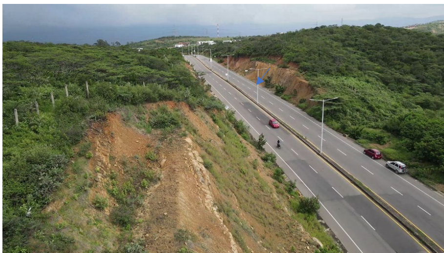
Figura 41. Tramo1, Talud prolongación avenida 0
