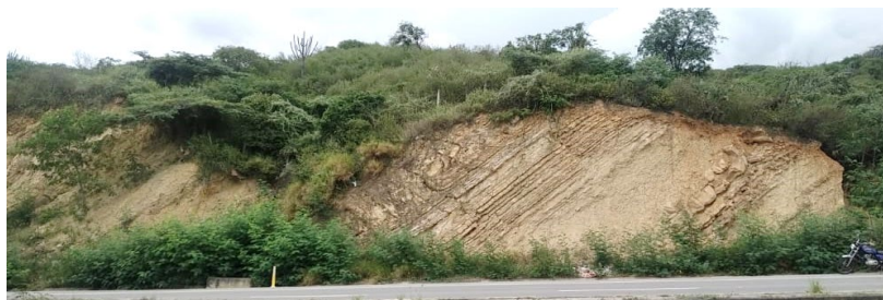
Figura 68. Vista parcial tramo 4
