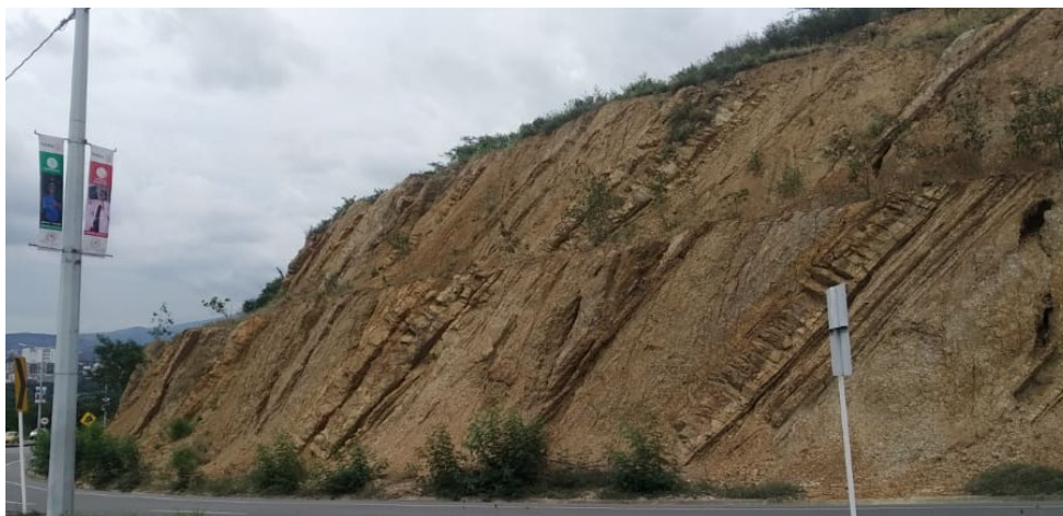
Figura 63. Vista parcial de la geometría o morfología del talud - tramo 2
