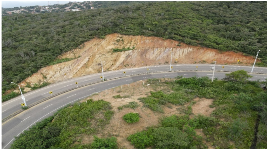
Figura 39. Talud prolongación Avenida 0
