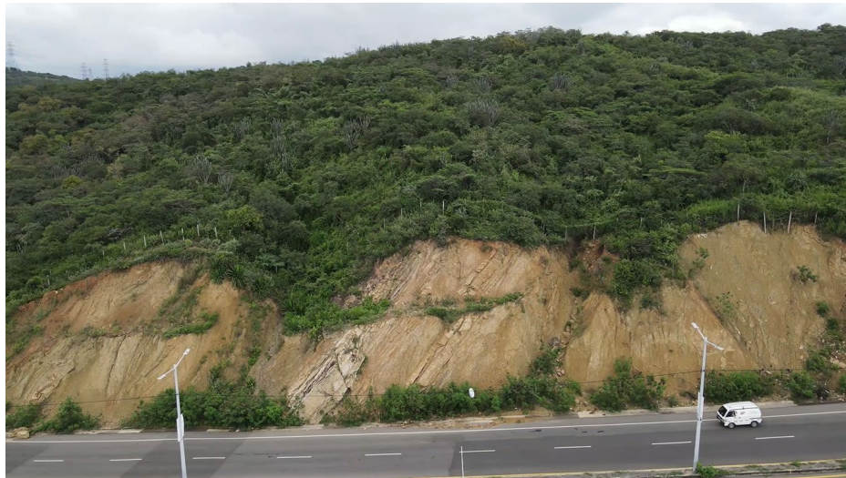
Figura 53. Tramo 4, Talud prolongación avenida 0
