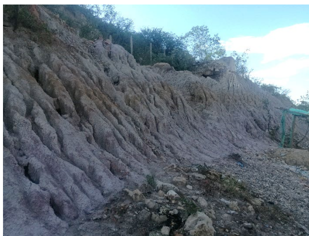
Figura 26. Vista general del talud N°7
