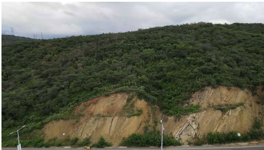
Figura 52. Tramo 4, Talud prolongación avenida 0
