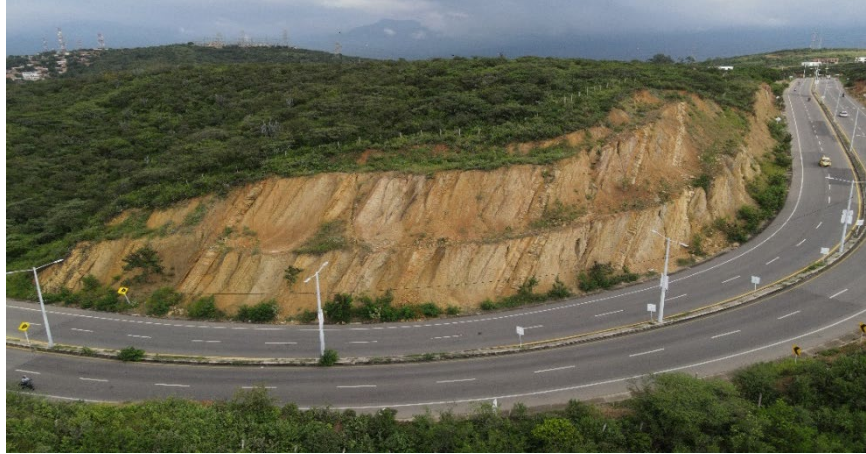
Figura 38. Talud prolongación Avenida 0
