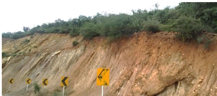
Figura 71. Vista parcial tramo 5
