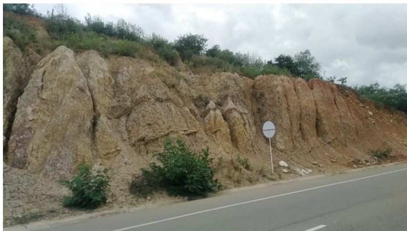
Figura 60. Vista parcial de la geometría o morfología del talud - tramo 1
