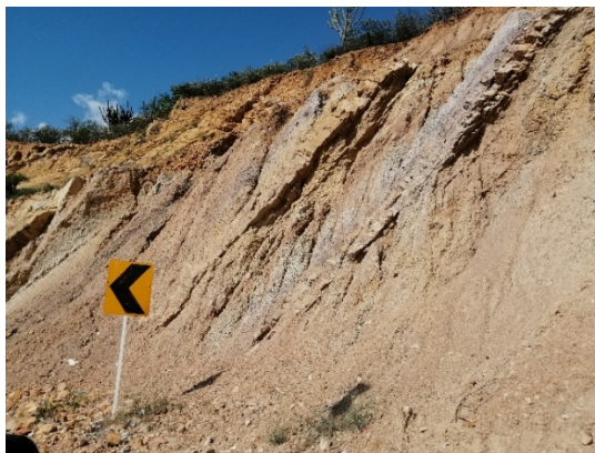
Figura 21. Vista general del talud N°3
