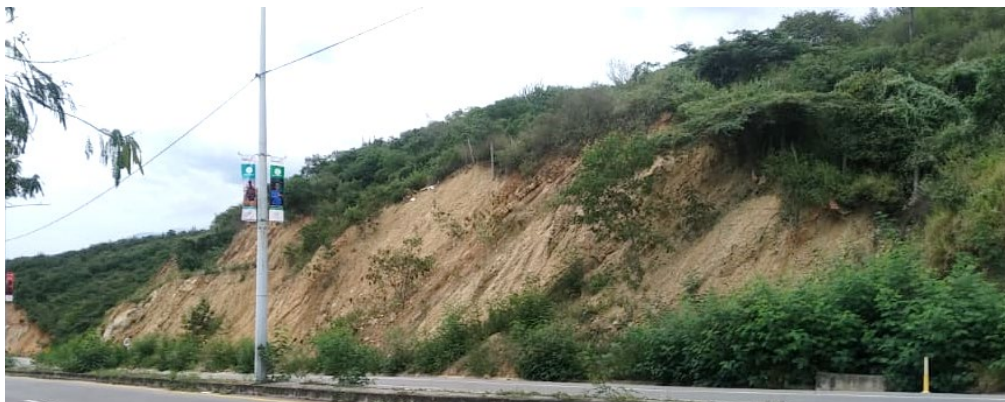
Figura 69. Vista parcial de la geometría o morfología del talud - tramo 4
