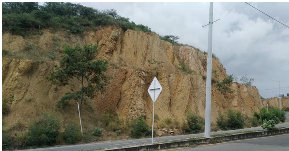
Figura 65. Vista parcial de la geometría o morfología del talud - tramo 3
