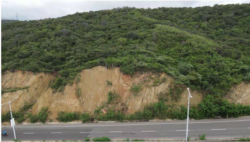
Figura 56. Tramo 4, Talud prolongación avenida 0
