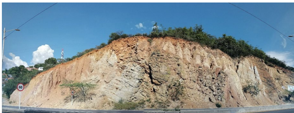
Figura 19. Vista general de la segunda parte del talud N°2 ubicado en la autopista internacional
