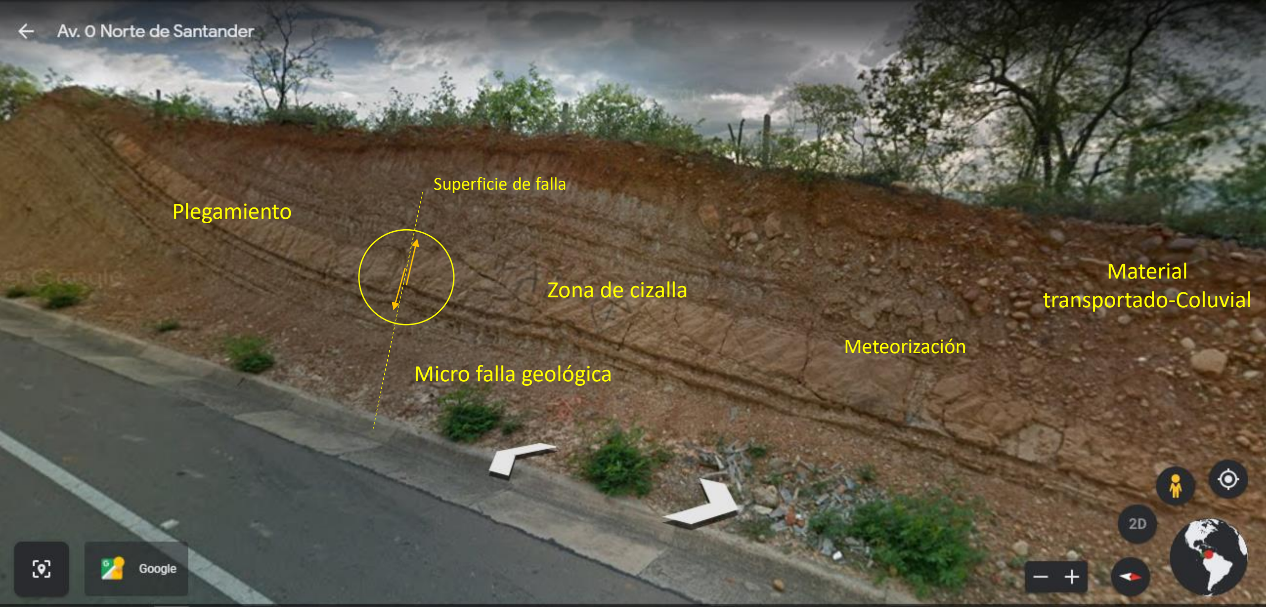
Algunos rasgos de la geología estructural visible en el talud sur de la vía. Álvaro Pedroza R – Julio 2021..
