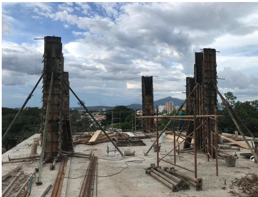
Figura 14. Encofrado de columnas
