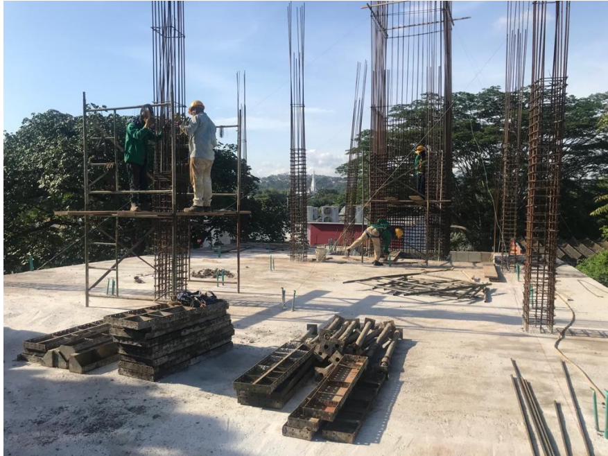
Figura 12. Armado de acero de refuerzo
