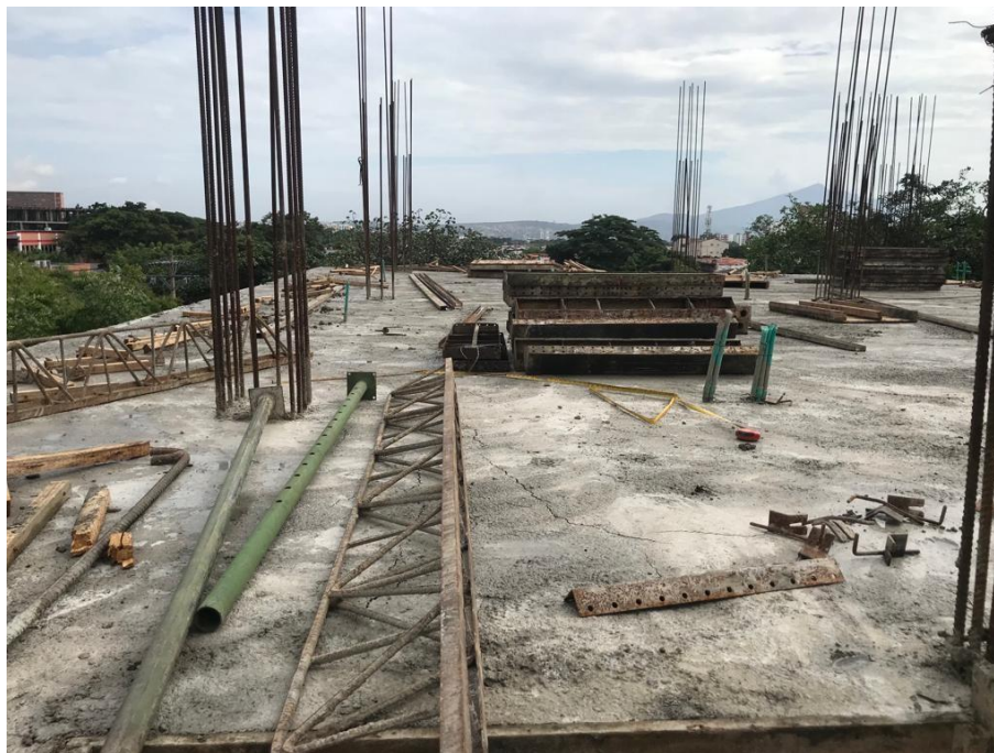
Figura 11. Localización de columnas
