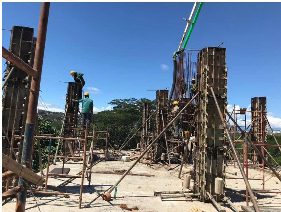
Figura 15. Vaciado de concreto y vibrador
