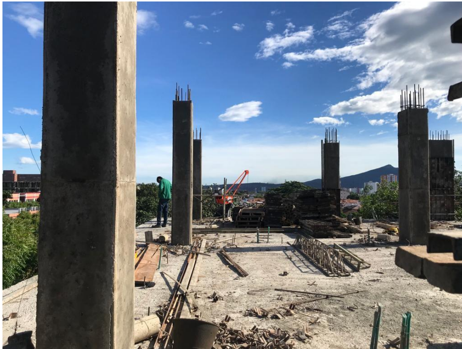
Figura 16. Desmoldado
