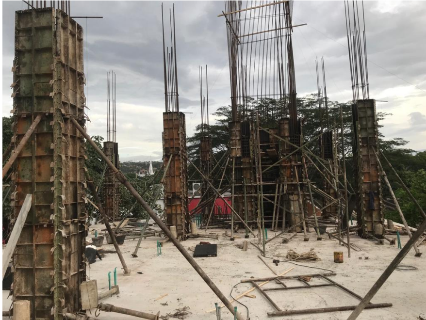
Figura 13. Colocación de separadores
