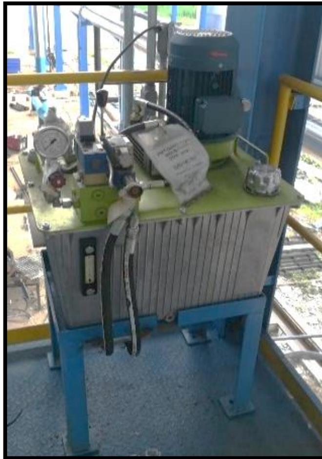
*Ilustración 1. Unidad hidráulica. Fuente: Elaboración propia.*
