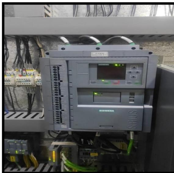
*Ilustración 30. Arrancador suave del digestor. Fuente: Elaboración propia.*
