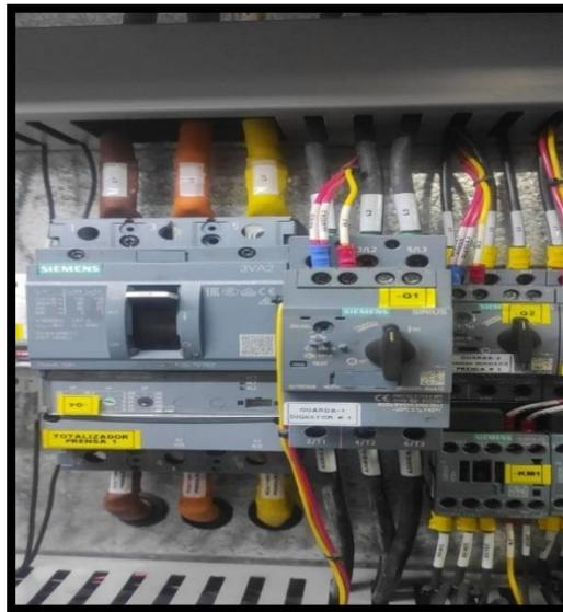
*Ilustración 28. Protección guardamotor de los equipos. Fuente: Elaboración propia.*
