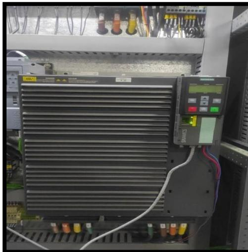
*Ilustración 29. Variador de frecuencia de la prensa. Fuente: Elaboración propia.*
