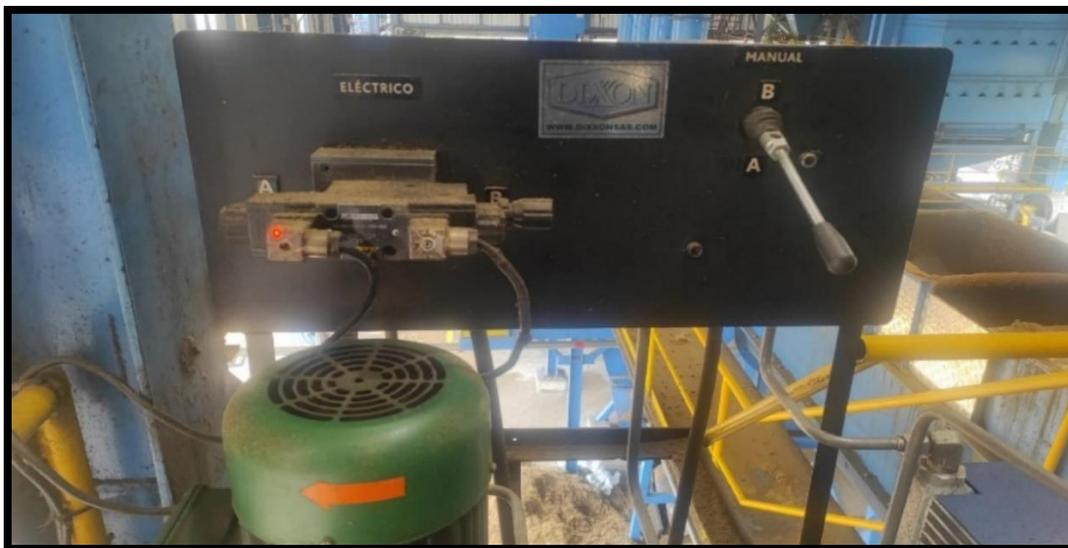
*Ilustración 25. Unidad hidráulica. Fuente: Elaboración propia.*
