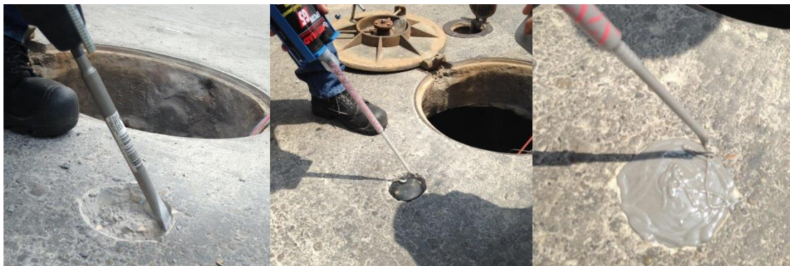
Figura 40. Apertura y sellado de las antenas de la ubicación B.
