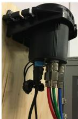
Figura 4. Conexión de mangueras para controlar el registrador de presiones [16].
