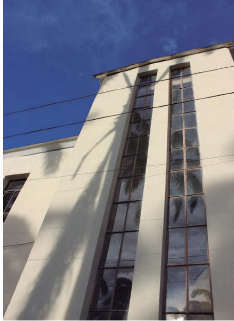
Figura 13. Fachada lateral de la Fundación Virgilio Barco
