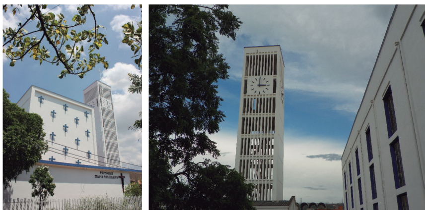
Figura 52. Fachada frontal y torre de la parroquia María Auxiliadora
