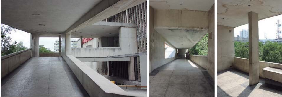
Figura 111. Fotografías de la rampa y circulaciones del edificio Teatro Rosetal
