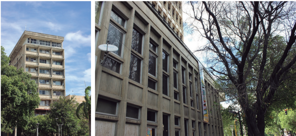
Figura 84. Vistas exteriores del edificio del antiguo Banco de la República
