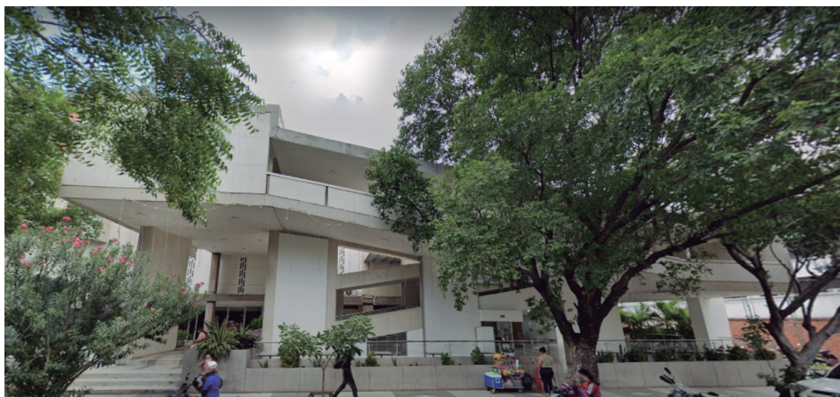
Figura 113. Vista externa de la rampa del edificio Teatro Rosetal
