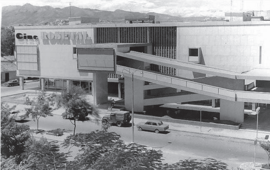
Figura 103. Imagen del edificio Teatro Rosetal
