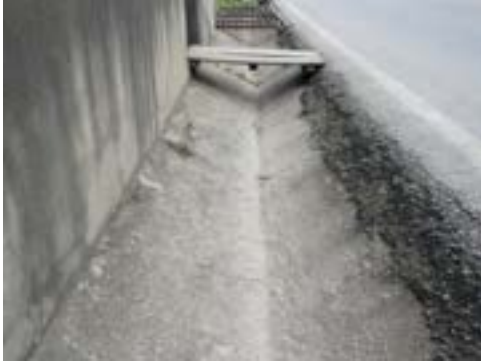
Figura 11. Canal con forma triangular. Canal de drenaje de vía principal
