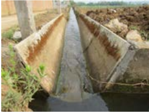
Figura 14. Canal con sección transversal parabólica
