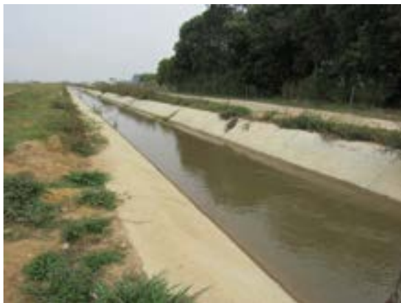
Figura 3: Canal de drenaje construido paralelo a una vía
