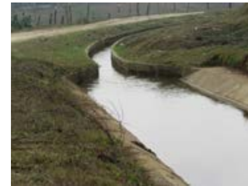
Figura 43. Ampliación de canal de drenaje
