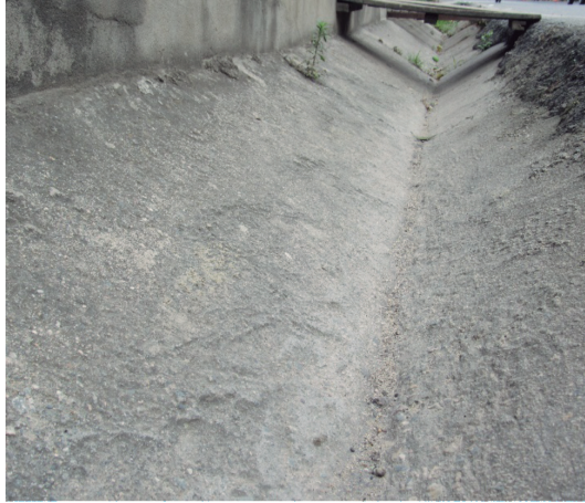
Figura 5. Canal muy rugoso en concreto
