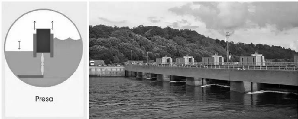
Figura 30. Presa de Marea.
