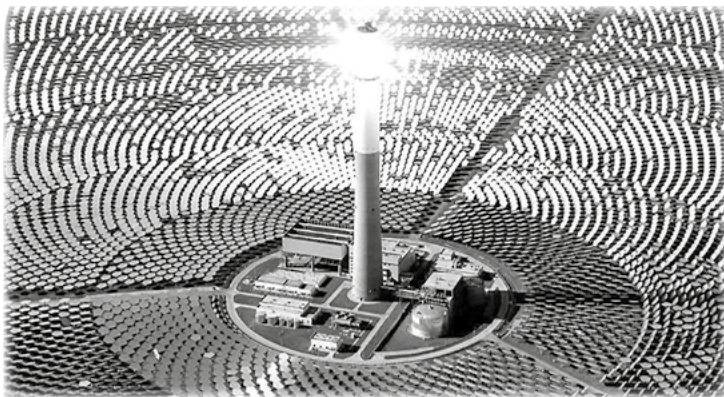
Figura 14. Planta termosolar Hami.
