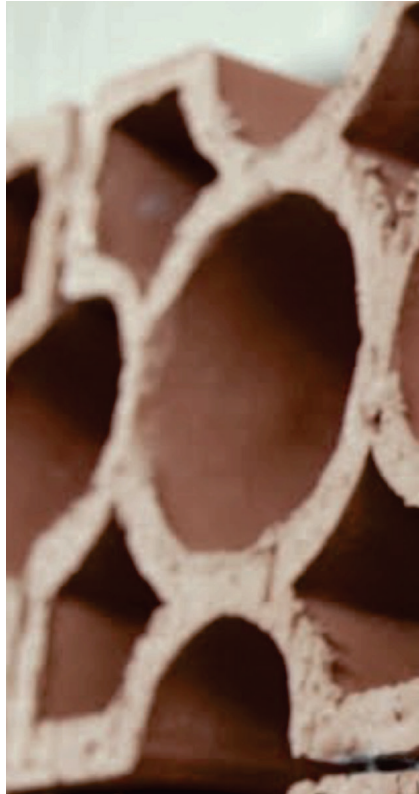
Figura 53. Fotografía de sistemas constructivos con calados cerámicos
