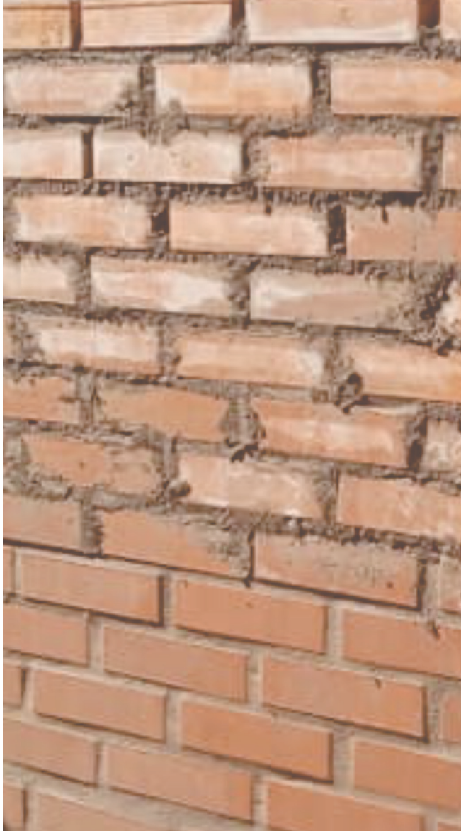
Figura 44. Fotografía de sistemas constructivos con ladrillos cerámicos
