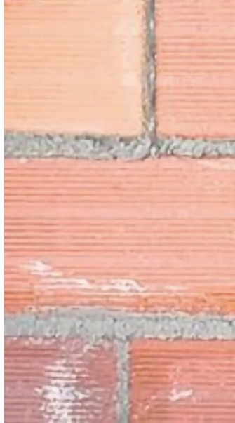
Figura 34. Fotografía de sistemas constructivos con bloques cerámicos
