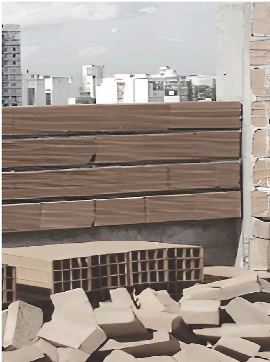
Figura 12. Construcción con productos cerámicos
