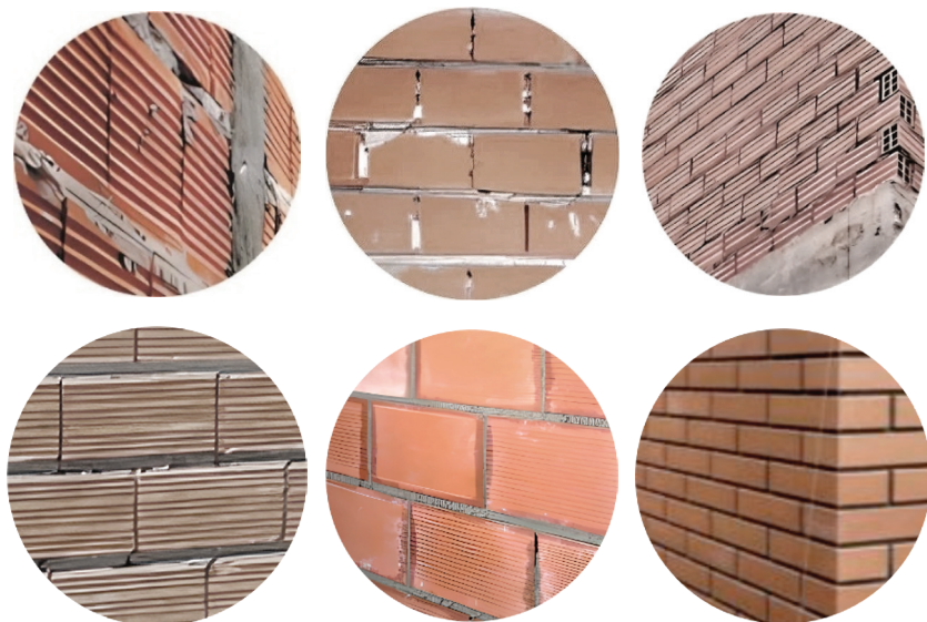
Figura 13. Mampostería de configuración cerrada
