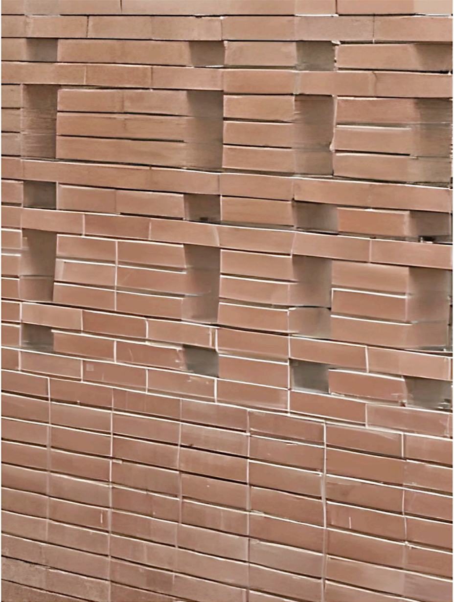
Figura 16. Construcción con productos cerámicos
