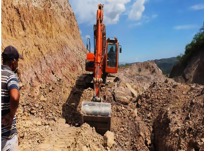
Figura 17. Registro fotográfico de la extracción de material arcilloso grupo Guayabo
