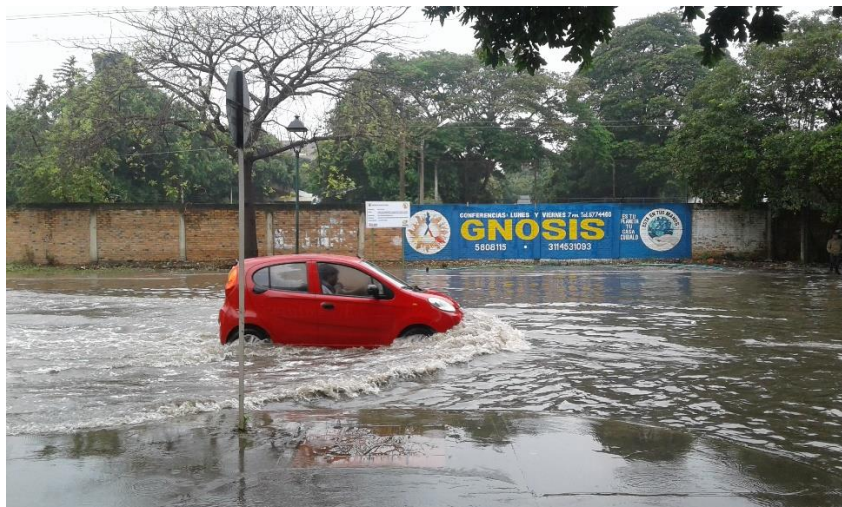
Figura 1. Problema actual de inundación en la zona de estudio
