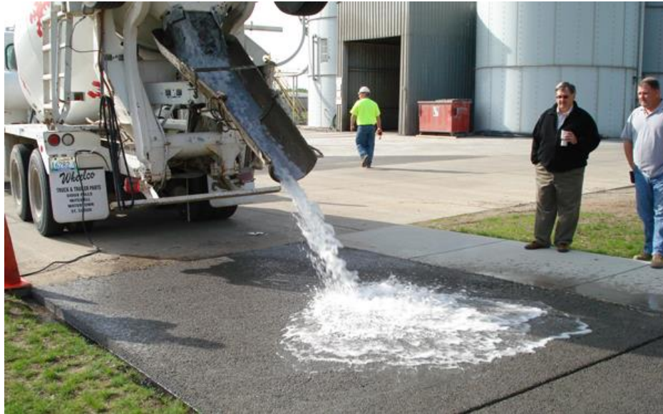
Figura 9.-Pavimento permeable- Concreto permeable
