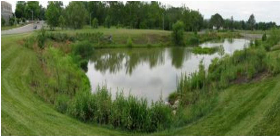
Figura 15.- Depósitos de detención
