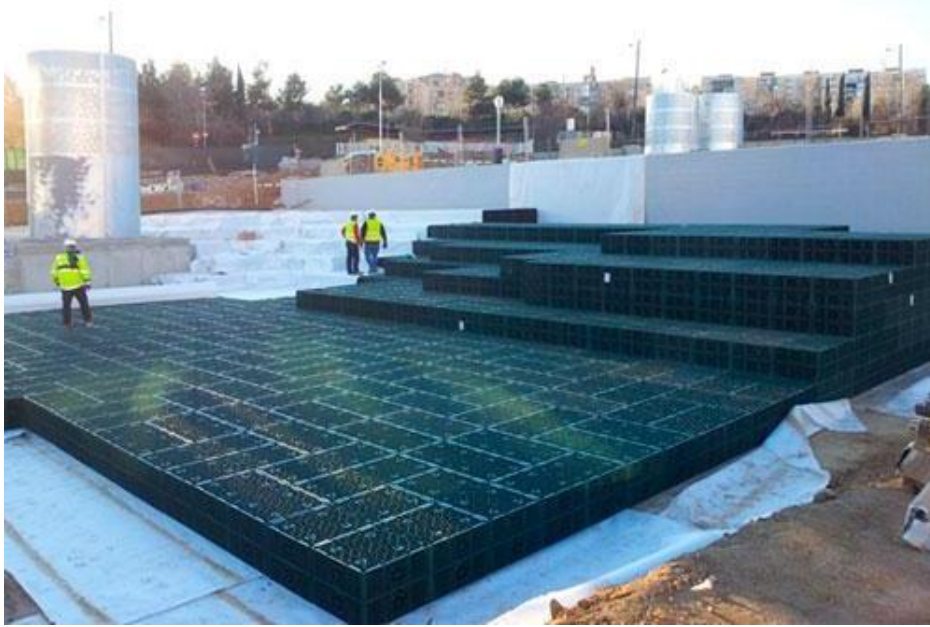
Figura 17. - Estanques de infiltración
