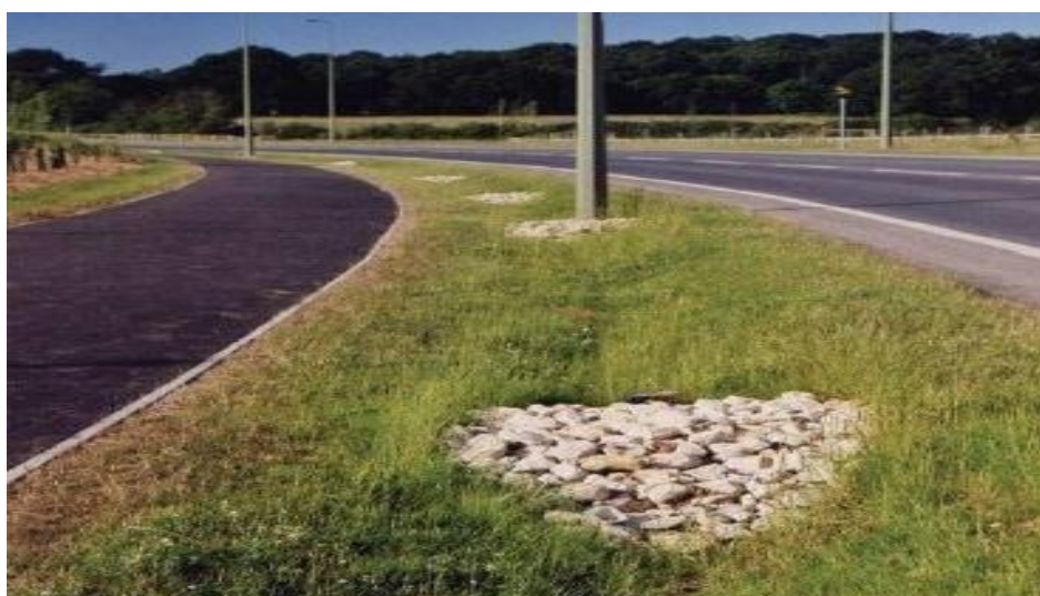
Figura 14.-Cunetas verdes o vegetadas (swales)
