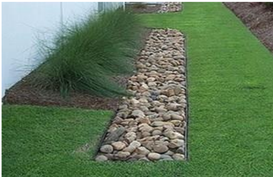
Figura 12.- Zanjas de infiltración
