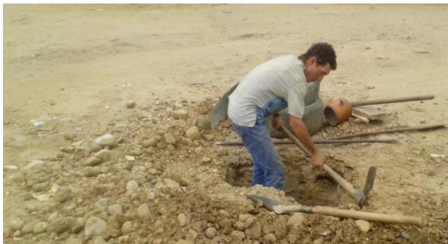
Ejecución apique número 1 de un metro de profundidad
