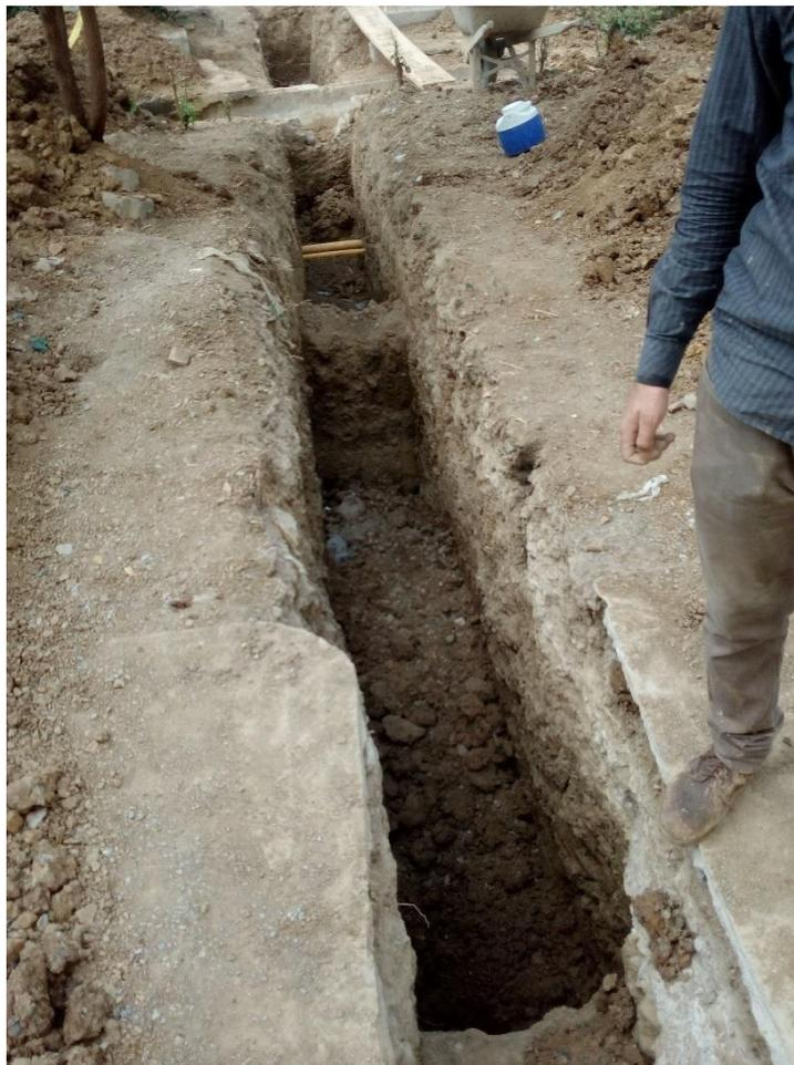
Fotografía 1. Sitio de la extracción de las muestras del apique 1, al momento de empezar las excavaciones para el proyecto, se estaban realizando una serie de zanjas para colocar un filtro francés al lado de la torre 28, estas zanjas tenían la profundidad adecuada para el estudio.
