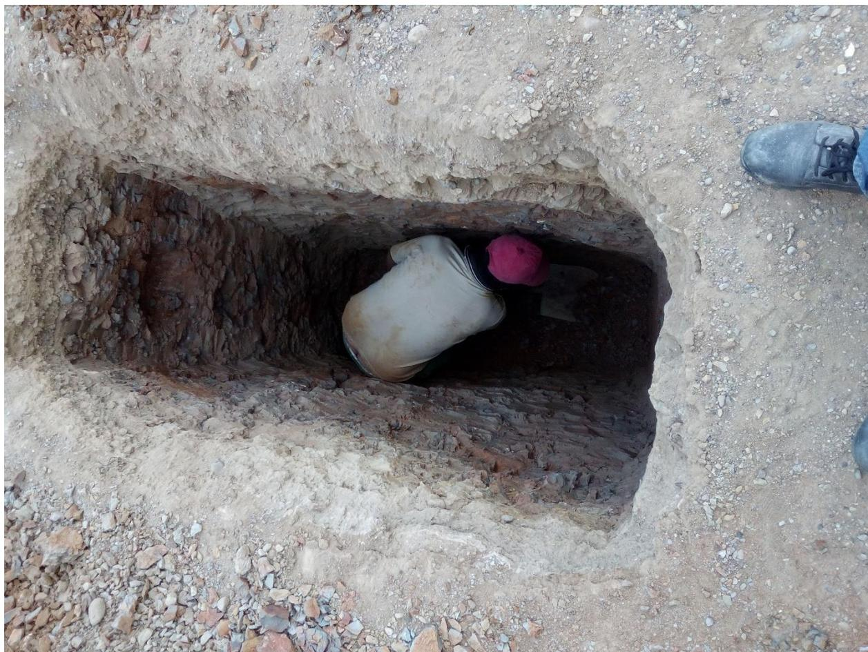
Fotografía 3. Apique No 3, se realizo en un área abierta al otro lado de la via principal de la urbanización, dimensiones: 2x0.9x2.9m
