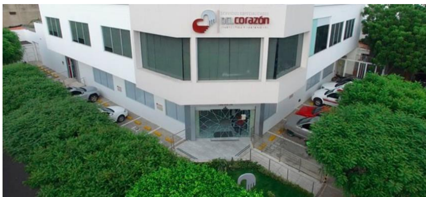
Ilustración 15. Fachada de la IPS
