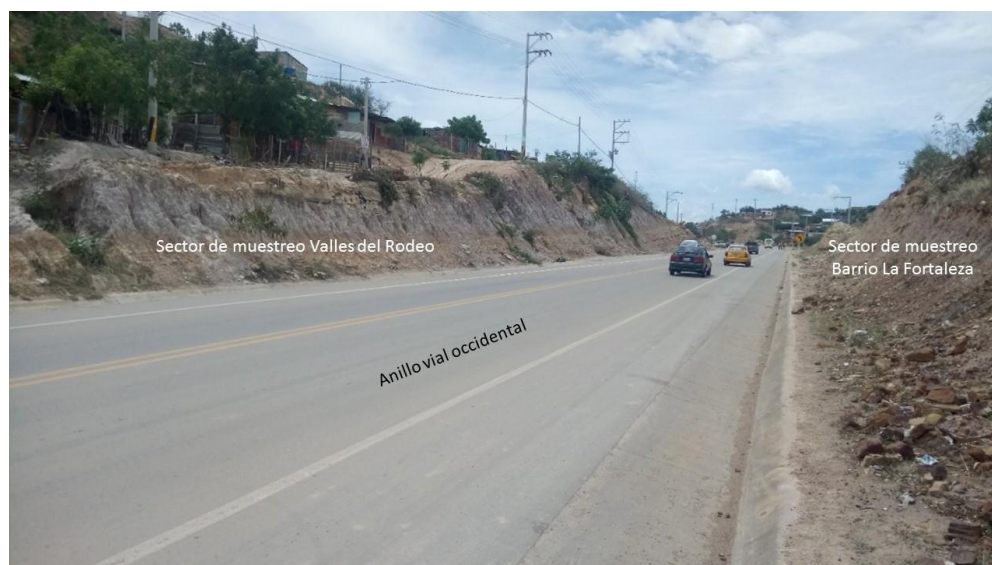
Figura 20. Sección en cajón del anillo vial occidental de Cúcuta. Taludes de muestreo, a la altura del Barrio La Fortaleza.
