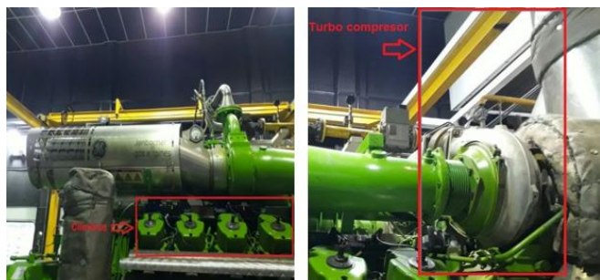
Figura 3: Turbo compresor y cilindros del motor. Fuente: elaboración propia.
