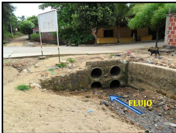
**Foto No. 12** Detalle de la estructura artesanal construida por la comunidad sobre la calle 3 que hace las veces de un Box Coulvert conformada por cuatro tubos de 24” revestidos en concreto y con una placa de concreto de espesor 0.25 metros.
