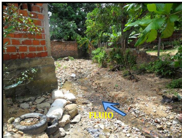
**Foto No. 14** Zona de la quebrada o toma entre la calle 3 y calle 2, se aprecia los linderos de varias viviendas, así como obstrucciones de escombros al flujo.
