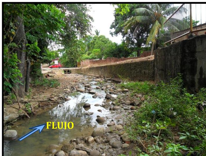
**Foto No. 10** Inicio del muro de contención en concreto ciclópeo sobre un costado de la quebrada o toma hacia la calle 3.
