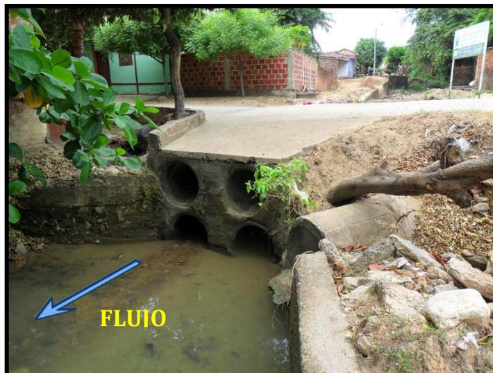
**Foto No. 13** Detalle de la estructura artesanal construida por la comunidad sobre la calle 3 que hace las veces de un Box Coulvert y la socavación ocasionada en los últimos años.
