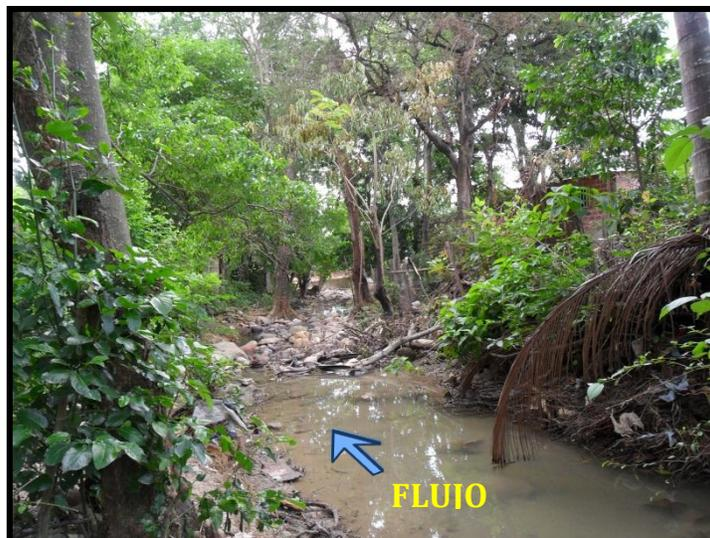
**Foto No. 9** Zona típica entre la calle 4 Y 3, se detecta la obstrucción al flujo del agua por rocas, árboles y maleza.
