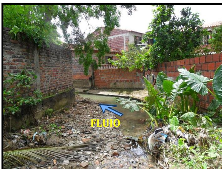
**Foto No. 16** Zona curva de la quebrada o toma entre la calle 3 y calle 2, se aprecia los linderos de varias viviendas, así como el estancamiento del agua ocasionada por la socavación del suelo en los últimos años.
