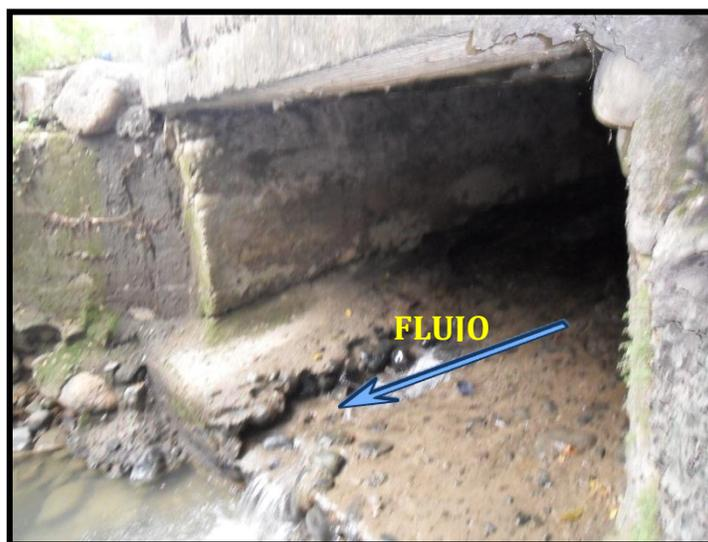
**Foto No. 4** Flujo del costado de quebrada o toma bajo el pontón ubicado en la calle 5; se advierte sobre la socavación de la placa base del pontón.
