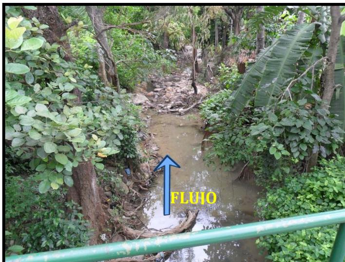
**Foto No. 7** Vista desde el pontón ubicado en la calle 4 hacia la calle 3, se muestra la obstrucción al flujo del agua por rocas y la espesa vegetación.
