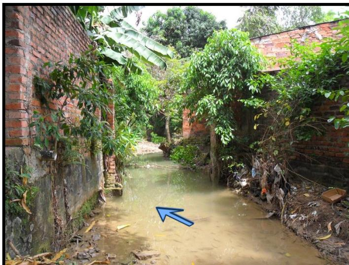
**Foto No. 15** Zona de la quebrada o toma entre la calle 3 y calle 2, se aprecia los linderos de varias viviendas, así como el estancamiento del agua ocasionada por la socavación del suelo en los últimos años.
