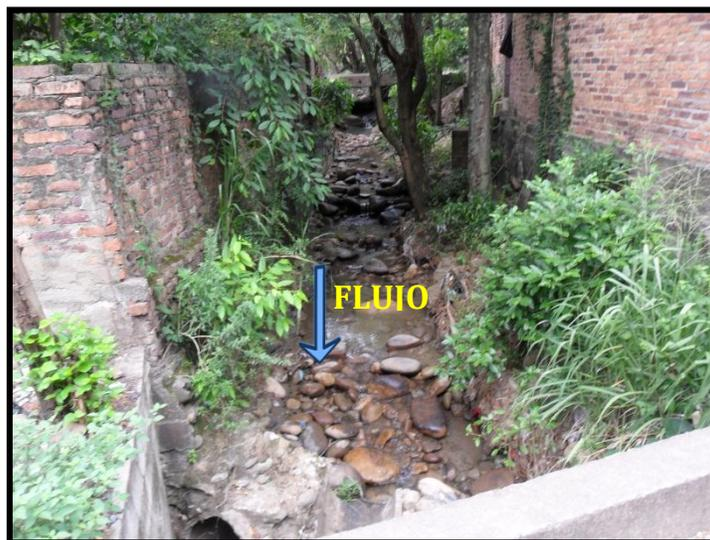
**Foto No. 6** Vista desde el pontón ubicado en la calle 4 hacia la calle 5, se muestra la obstrucción al flujo del agua por rocas, árboles y maleza. También se aprecia la exposición de las casas aledañas a una eventual inundación.
