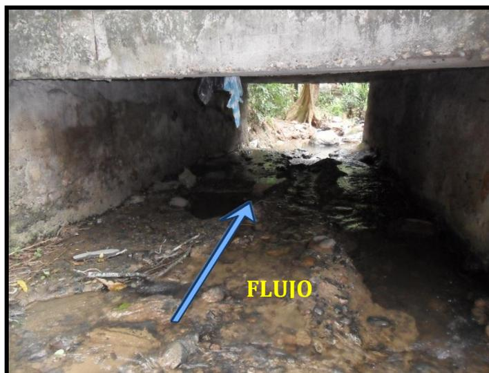
**Foto No. 3** Flujo de costado de la quebrada o toma bajo el pontón ubicado en la calle 5; se observa la excesiva acumulación de sedimentos y basuras.
