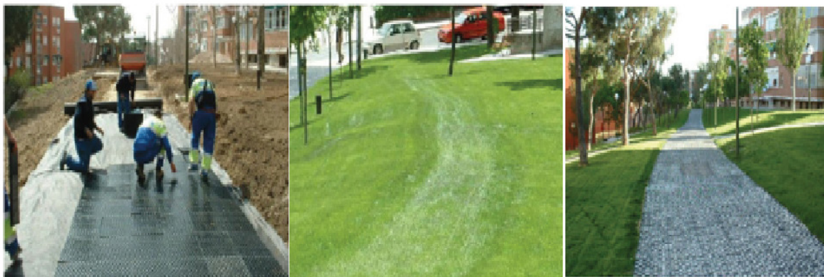
Figura 7. Instalación de celdas de drenaje bajo pavimento permeable-parque Gomeznarro.
