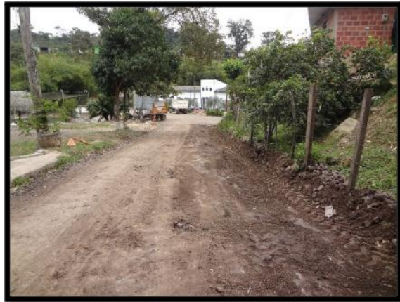
Figura 19. Carpeta asfáltica y Base granular retiradas en parte del tramo 1
