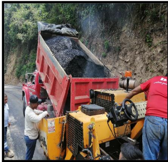
Figura 71. Descarga de asfalto en la tolva del finisher
