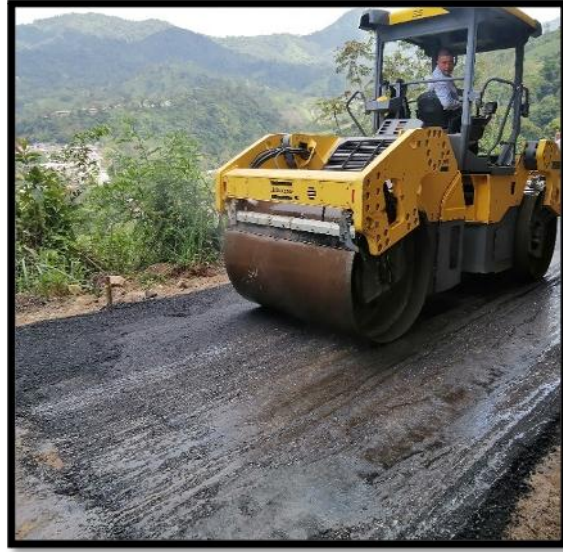
Figura 78. Compactación del asfalto
