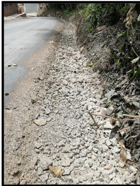
Figura 102. Pedraplen instalado en tramo 2
