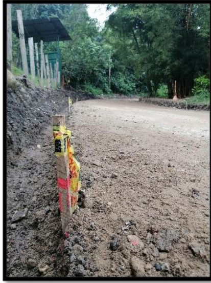
Figura 34. Demarcación altura de la base granular
