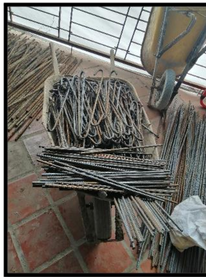
Figura 86. Ganchos longitud 0.60 m Calibre 3/8
