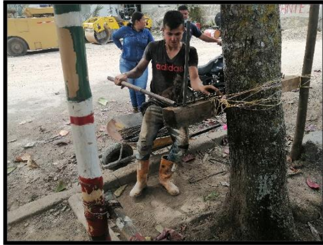
Figura 85. Doblado del acero para cunetas y bordillos
