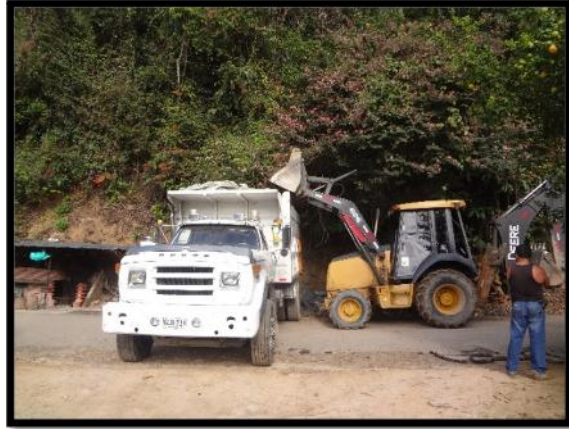
Figura 18. Cargue de escombros en volquetas
