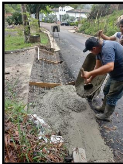
Figura 91. Fundida de cunetas y bordillos
