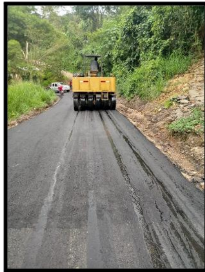
Figura 79. Sellamiento del asfalto recién compactado
