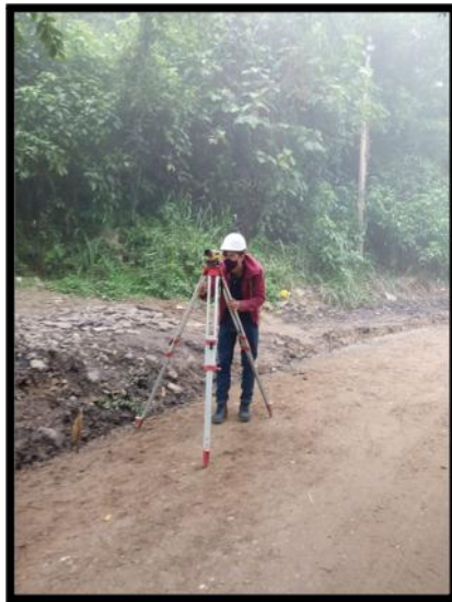
Figura 25. Nivel topográfico en parte del tramo 1
