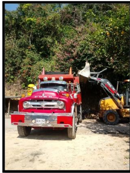
Figura 17. Cargue de escombros en volquetas
