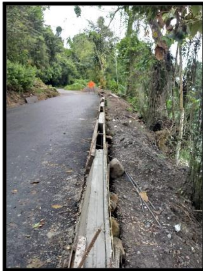
Figura 95. Bordillos por módulos de 2.40 m
