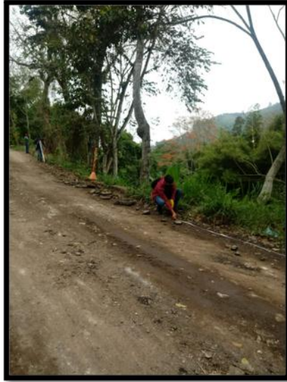
Figura 24. Medición de la vía cada 5 metros en parte del tramo 1
