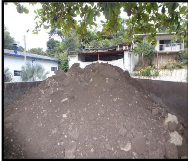
Figura 29. Sub base granular extraída
