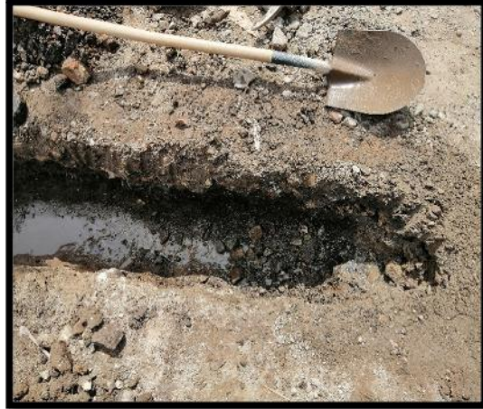
Figura 103. Excavación para pedraplen
