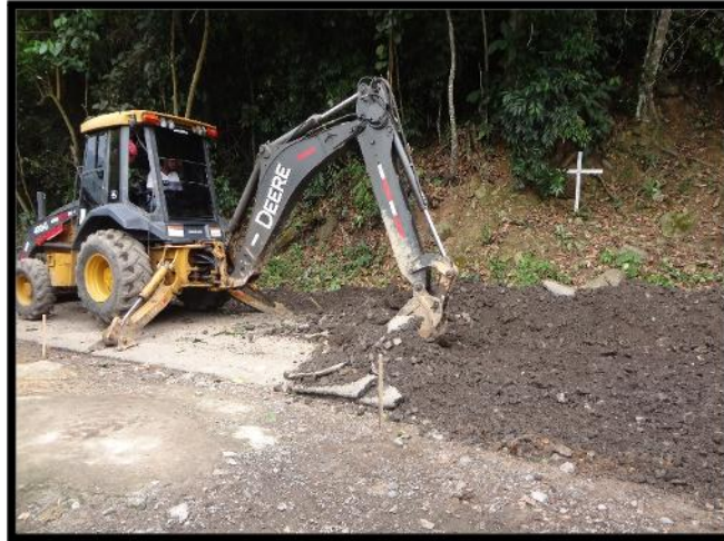
Figura 12. Escarificación en tramo 2
