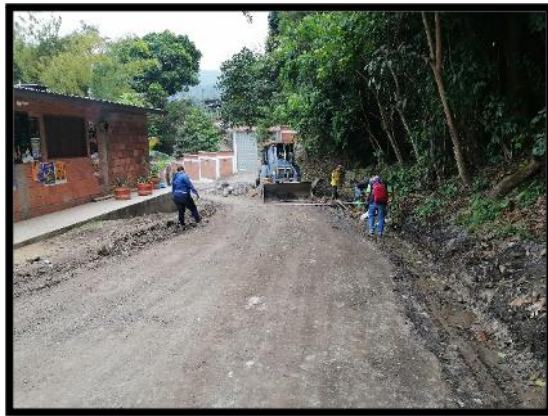
Figura 27. Medición de la vía cada 5 metros en parte del tramo 2
