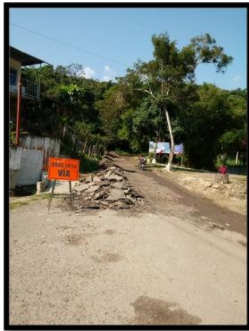
Figura 3. Señalización inicio de obra K0+000
