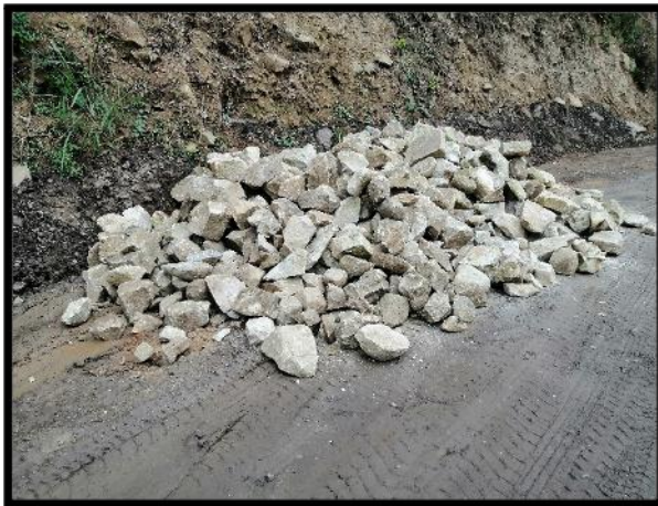
Figura 99. Piedra rajón para filtro en tramo 3
