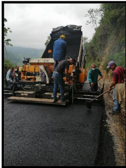
Figura 73. Tornillero asegurando la debida altura del material extendido
