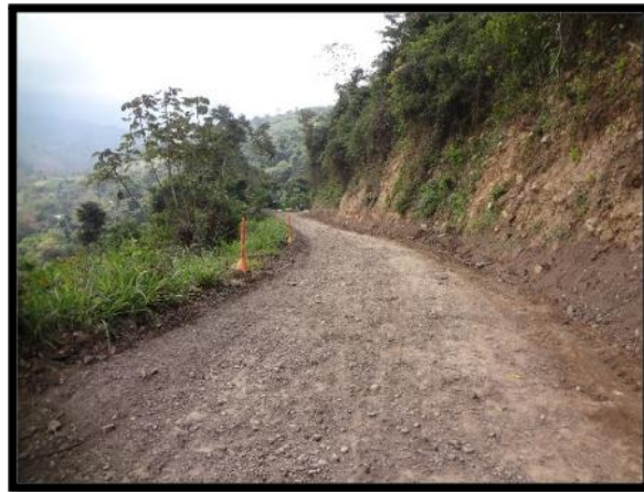
Figura 21. Carpeta asfáltica y Base granular retiradas en parte del tramo 3
