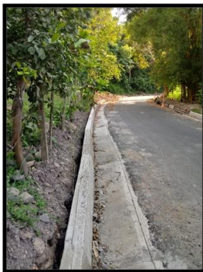
Figura 95. Bordillos por módulos de 2.40 m
