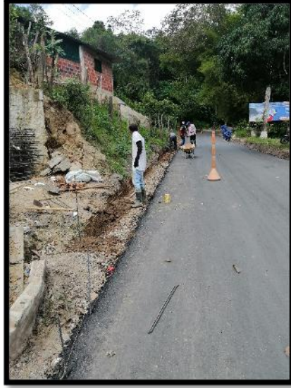
Figura 89. Excavación manual para cunetas y bordillos
