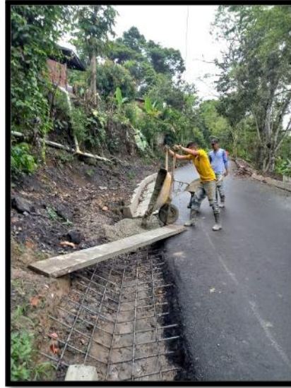
Figura 91. Fundida de cunetas y bordillos
