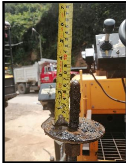
Figura 69. Tornillo calibrado en 6 cm para carpeta asfáltica
