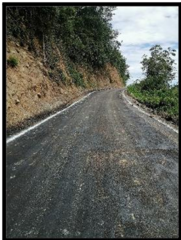
Figura 63. Suelo después de imprimación
