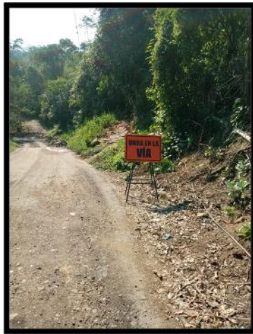
Figura 4. Señalización final de obra K1+560
