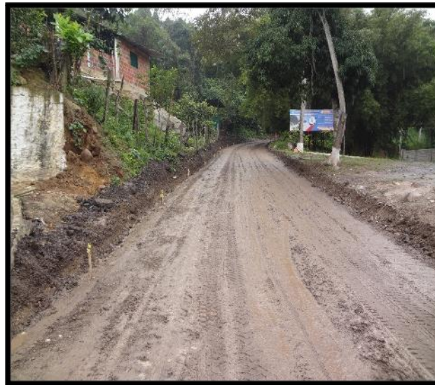
Figura 33. Conformación base granular tramo 1
