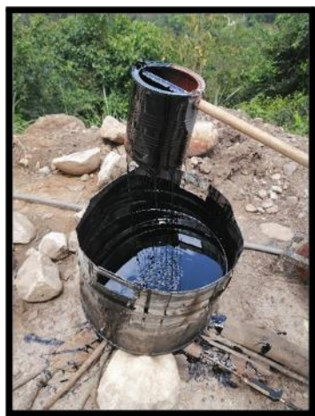
Figura 64. Emulsión asfáltica para mayor adhesión del asfalto
