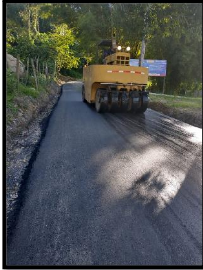
Figura 80. Sellamiento del asfalto recién compactado
