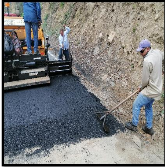
Figura 74. Distribución y rastrille del material extendido
