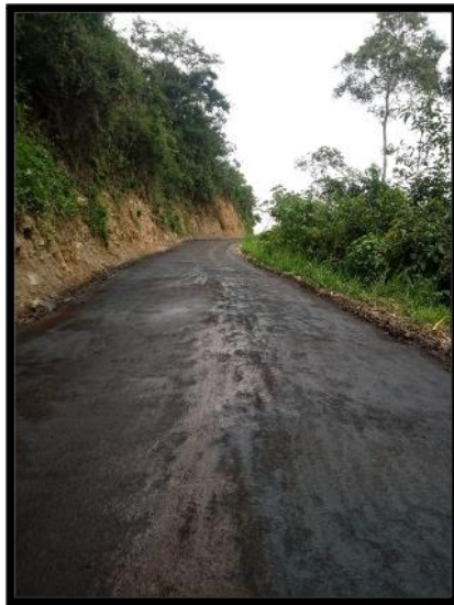
Figura 61. Suelo después de imprimación
