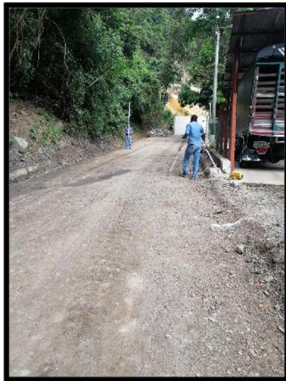
Figura 28. Nivel topográfico en parte del tramo 3
