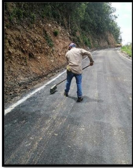
Figura 70. Limpieza de polvo y material suelto para instalación de asfalto
