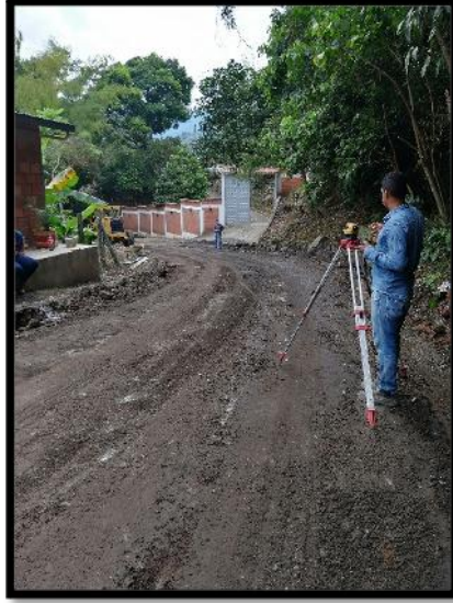
Figura 26. Nivel topográfico en parte del tramo 2
