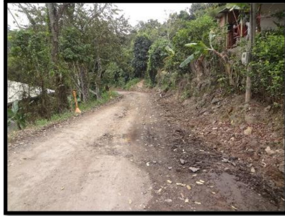
Figura 20. Carpeta asfáltica y Base granular retiradas en parte del tramo 2
