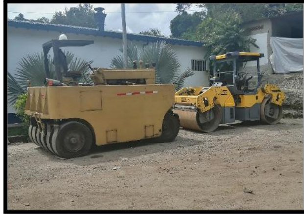
Figura 68. Vibroccompactador y sellador de asfalto
