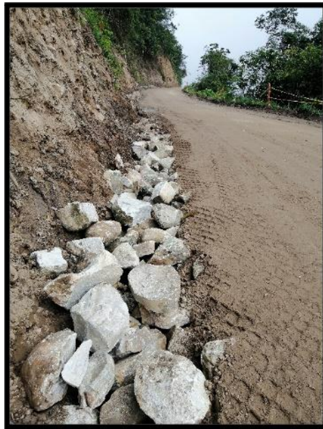
Figura 101. Pedraplen instalado en tramo 3
