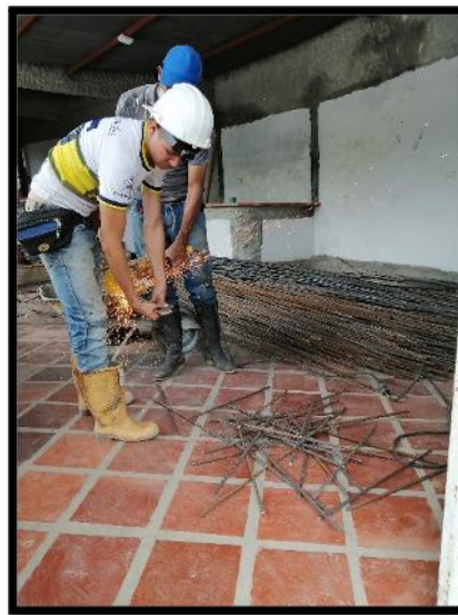
Figura 84. Corte del acero para figurado de cuneta y bordillo
