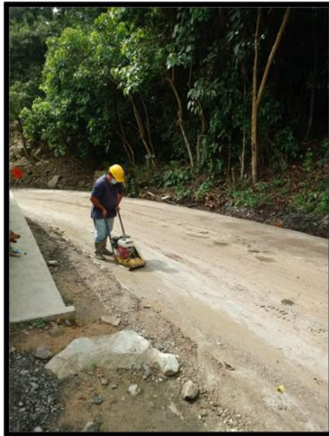
Figura 106. Compactación para ensayo de densidad
