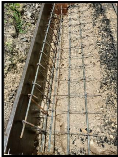
Figura 90. Encofrado y figurado del acero para cunetas
