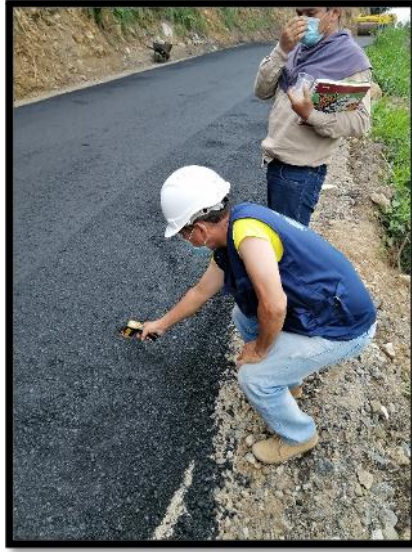
Figura 76. Toma de temperatura para la compactación (85-90 C°)
