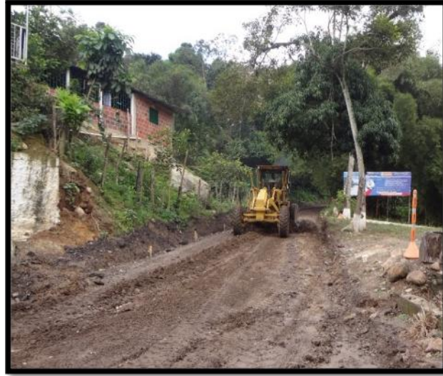
Figura 32. Conformación base granular tramo 1
