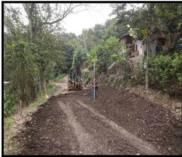
Figura 30. Sub base granular en la vía
