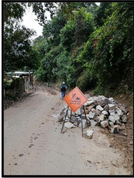
Figura 100. Piedra rajón para filtro en tramo 2
