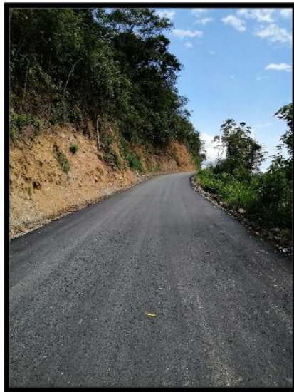
Figura 81. Pavimento flexible instalado
