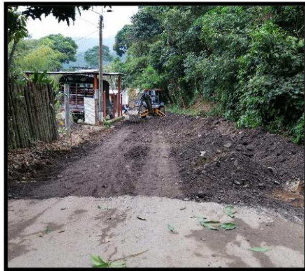
Figura 11. Escarificación en tramo 2
