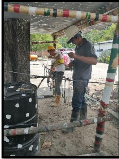
Figura 87. Armado del figurado para cunetas
