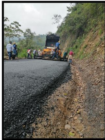
Figura 75. Instalación del material asfáltico
