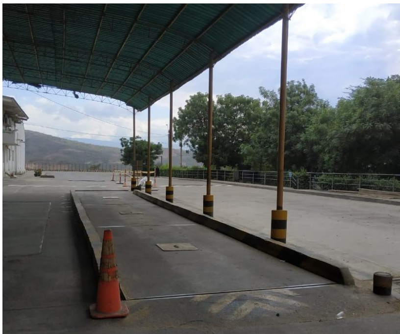
Figura 35. Báscula camionera (instalaciones molino oro).
