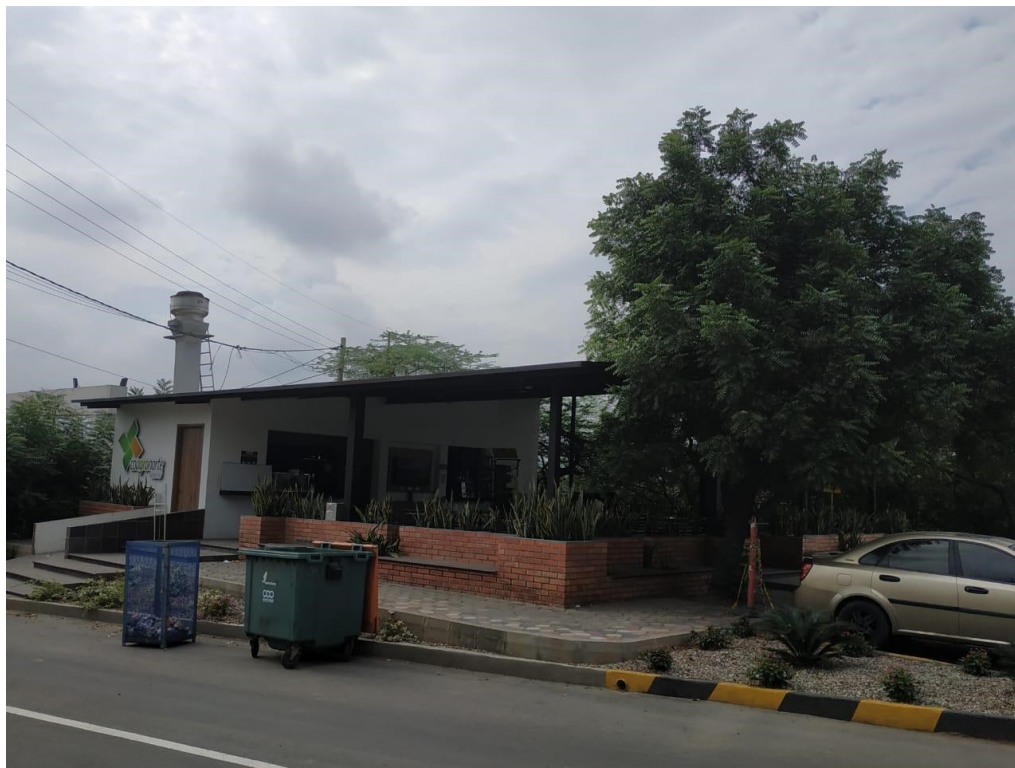
Figura 33. Cafetería (instalaciones molino oro).
