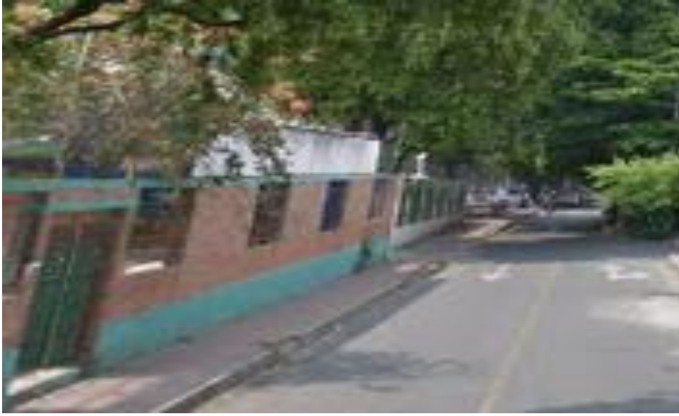
Pavimento flexible buen estado
