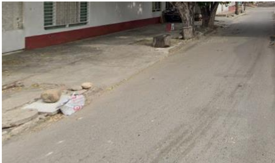
Pavimento flexible buen estado
