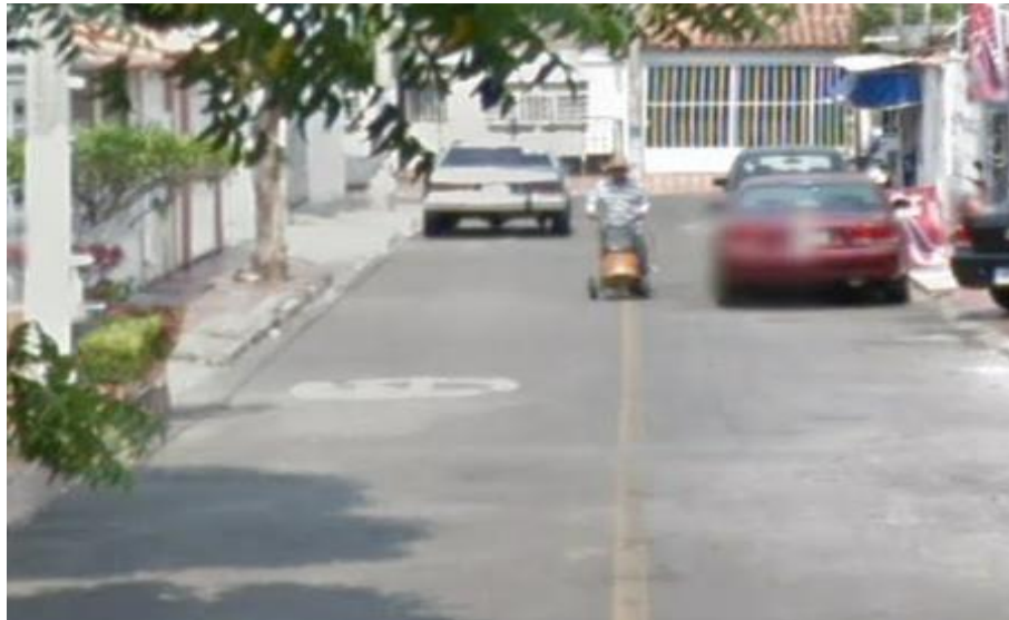
Pavimento flexible buen estado
