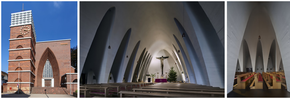
Figura 2. Vista exterior e interior y planta de la iglesia Christ-König en Bischofsheim (1926), de Dominikus Böhm
