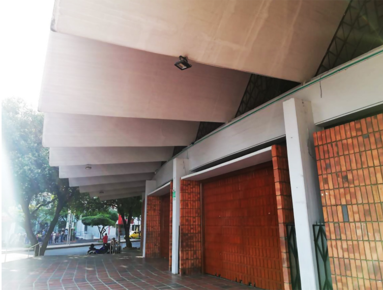
Figura 44. Detalle de la cubierta en el voladizo de la iglesia de Nuestra Señora del Carmen
