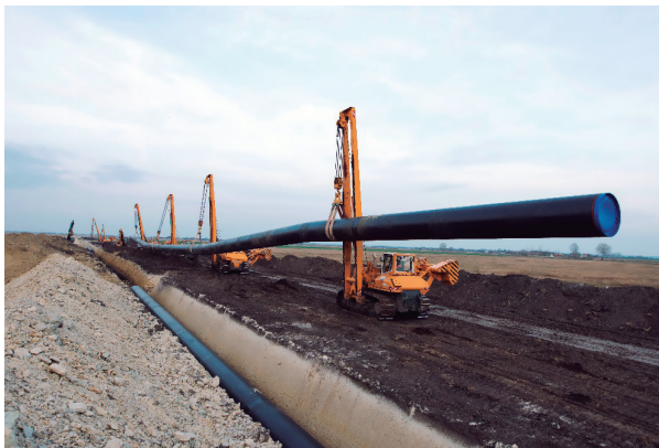
Figura 18. Transporte por tuberías
