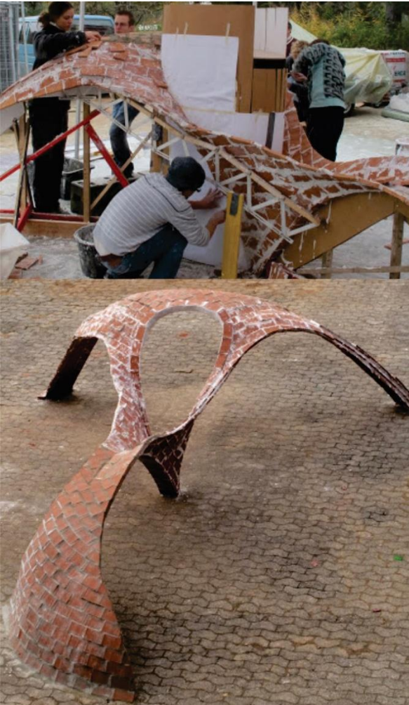
Figura 5. Prototipo Superficie Compleja en Ladrillos a Escala 1:1
