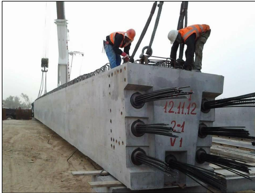
Figura 3. Imagen de una viga en concreto postensado de un puente.
