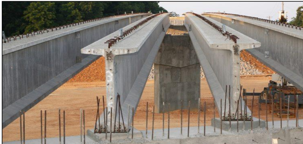
Figura 2. Sección de unas vigas en I de un puente en concreto reforzado.
