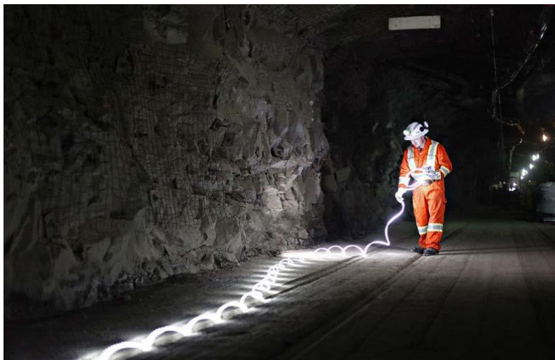
Figura 43. Unión de carretes de cinta led para instalar en un túnel
