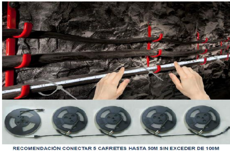
Figura 44. Instalación cinta led interconectable en un túnel
