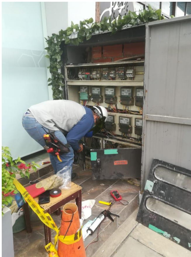
Figura 26. Conexión al barraje con equipo de seguridad.
