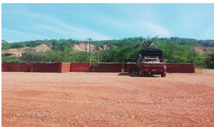
Figura 13. Zona de carga almacenamiento final
