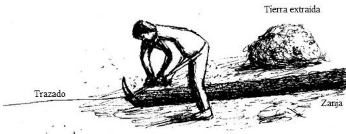
Figura 27. Zanja para la instalación sanitaria.
