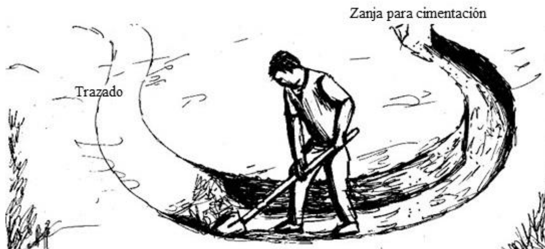
Figura 29. Excavación de zanjas para la cimentación.
