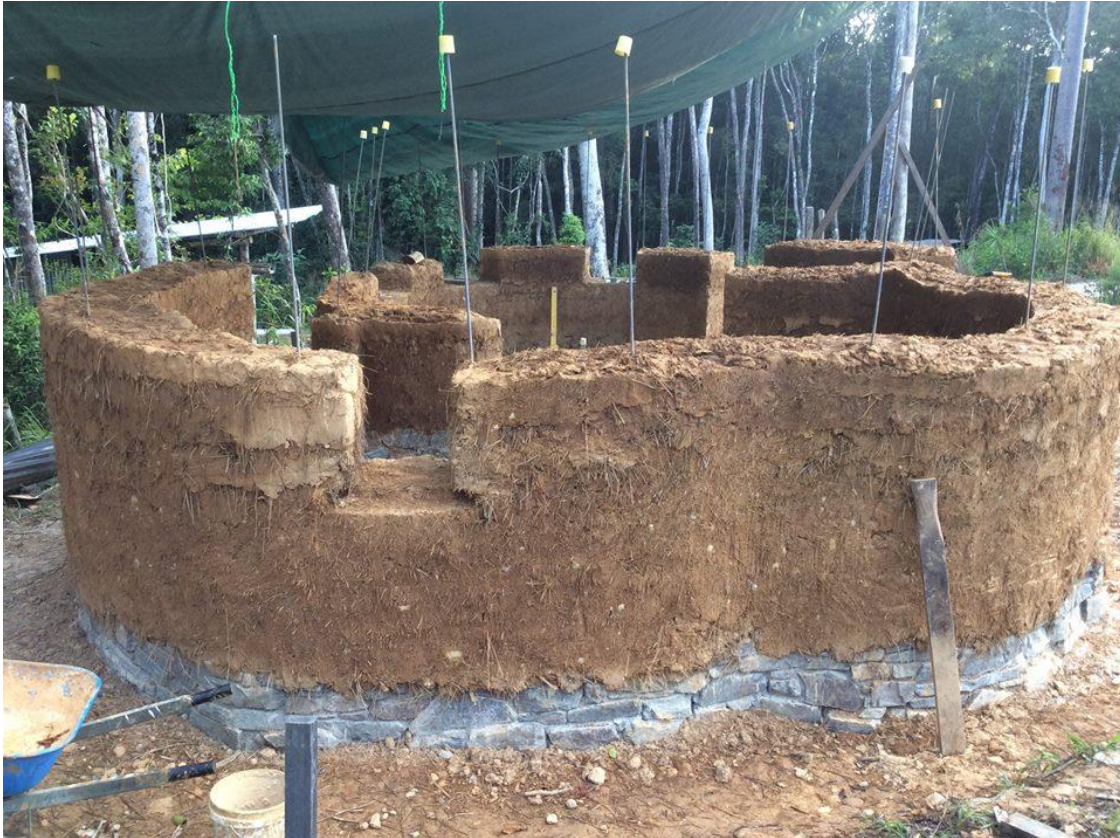
Fotografía 34. Muro de Cob. Cluever (2016).
