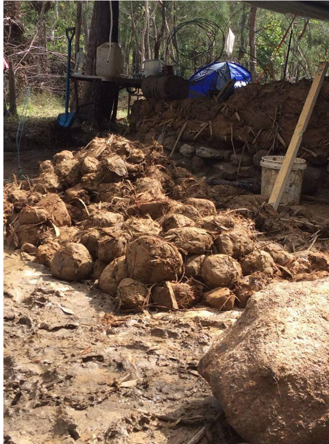
Fotografía 32. Mezcla de barro con paja lista para aplicar sobre el muro. Cluever (2016).
