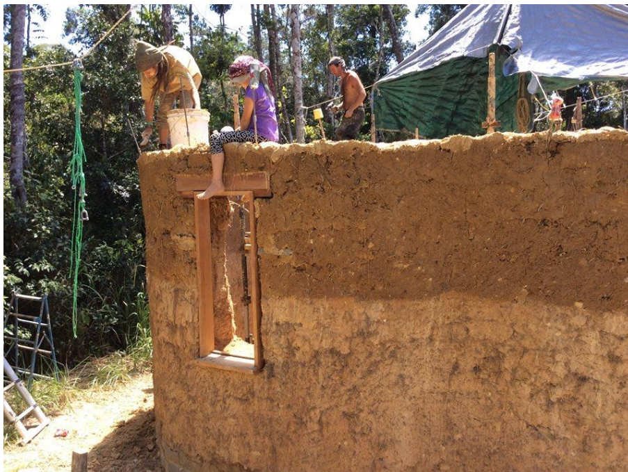
Fotografía 33. Levantamiento de un muro de Cob. Cluever (2016).
