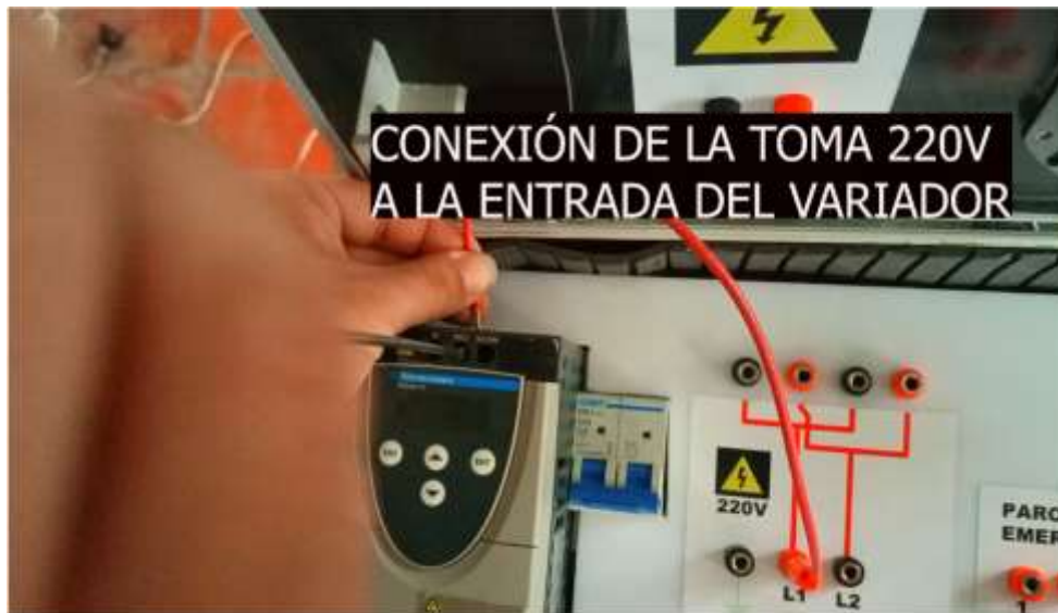
Figura 33. Conexión de la toma 220V al variador
