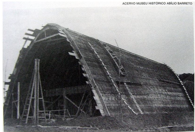
Imagen 3. Fotografía proceso constructivo. Iglesia de San Francisco de Asís, Brasil
