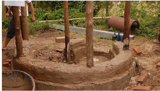
Figure 4. Constructive technique Cob Source: Tierra al Sur Arquitectura Construcción
