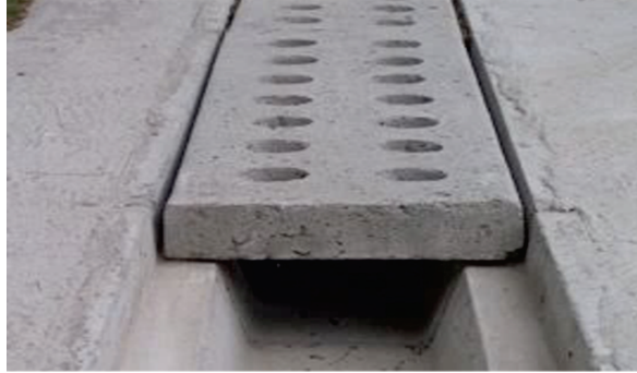
Figura 44. Sistemas de drenajes con placas prefabricadas
