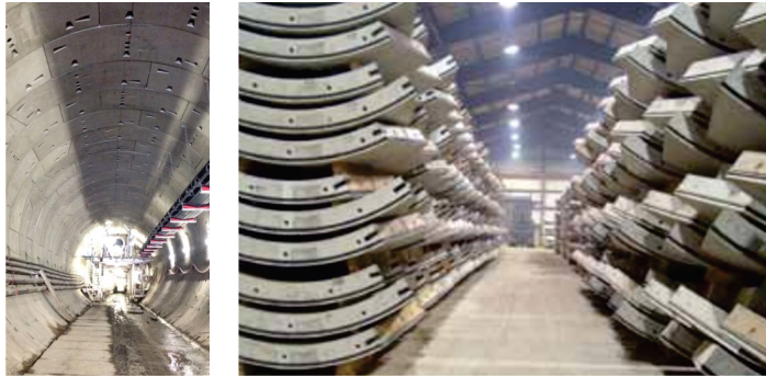
Figura 52. Revestimiento de túnel en dovelas mediante concreto armado con fibras de acero. Cortesía de Bekaert Corp. EE. UU
