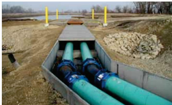
Figura 45. Aplicación de zanjas de tuberías de concreto reforzado con fibra de vidrio. Cortesía de Nippon Electric Glass America Inc
