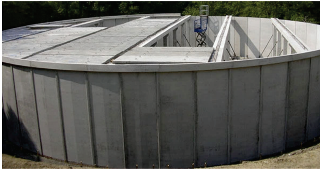
Figura 42. Tanques construidos con placas prefabricadas
