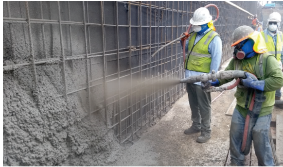
Figura 48. Concreto lanzado
