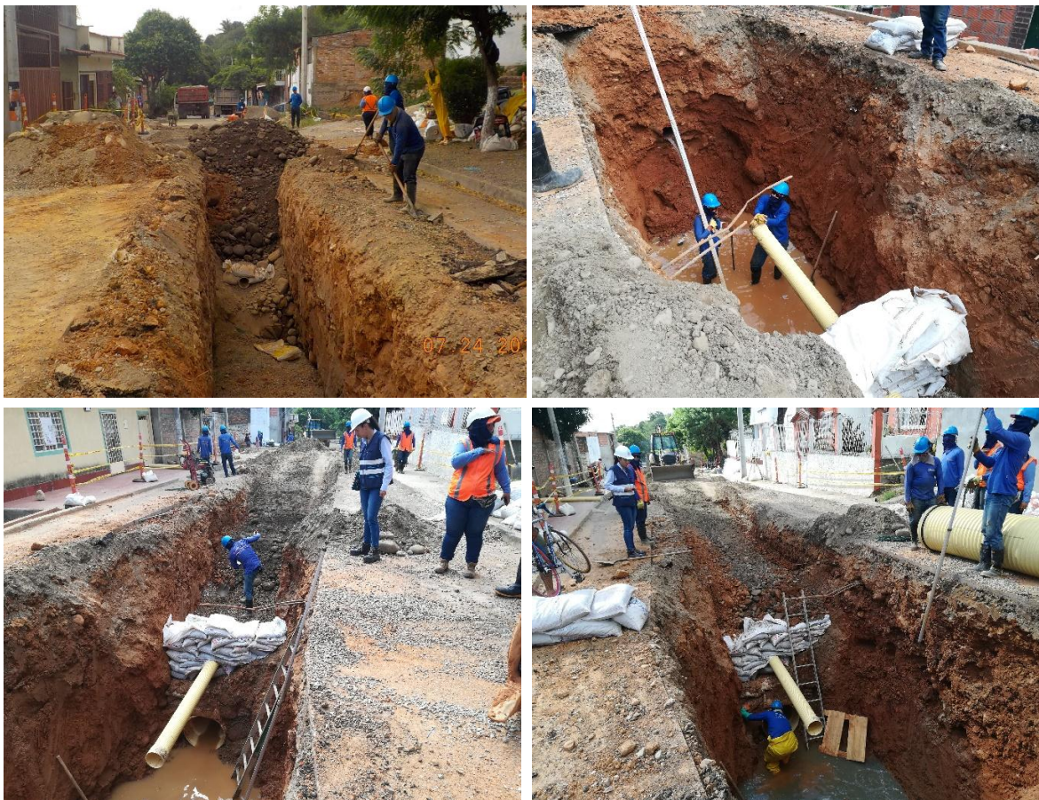
Figura 72. Reposición de alcantarillado en la subida La Chivera
