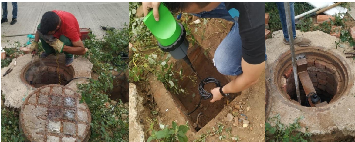
Figura 46. Instalación del medidor LT-US Sofrel
