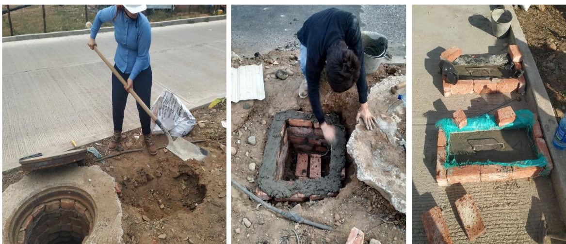
Figura 45. Construcción de caja para el medidor Lt-US Sofrel
