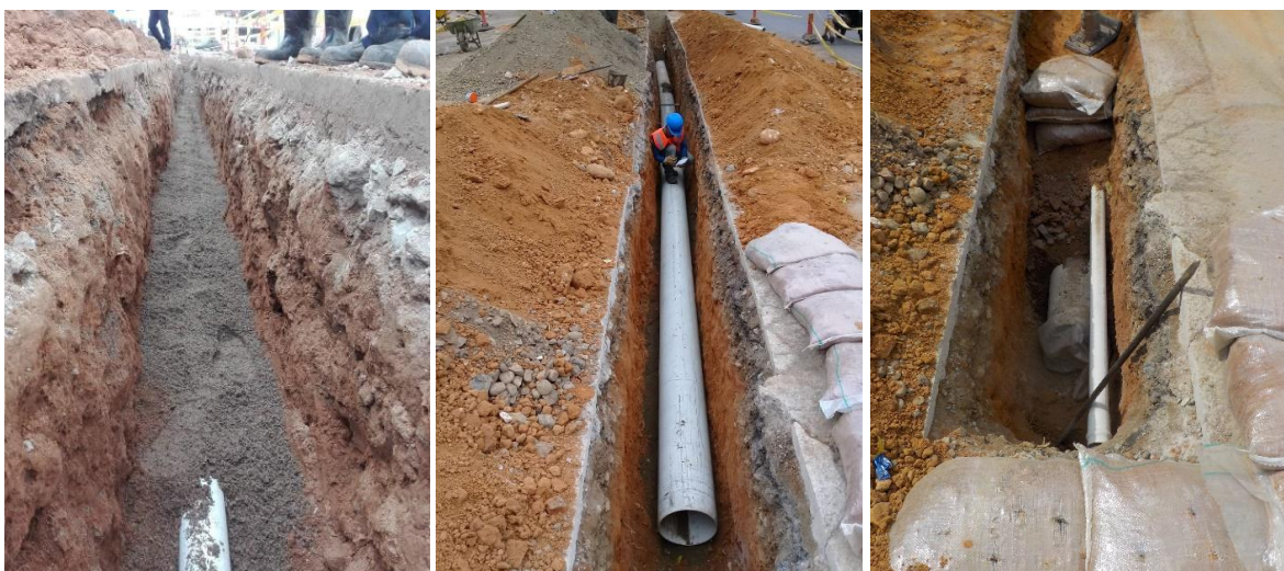
Figura 74. Reposición de alcantarillado en el barrio San Luis
