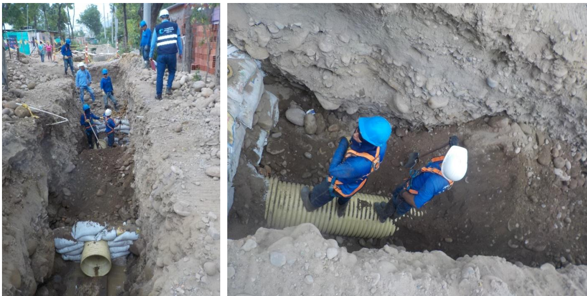
Figura 73. Reposición de alcantarillado sobre la Avenida Demetrio Mendoza
