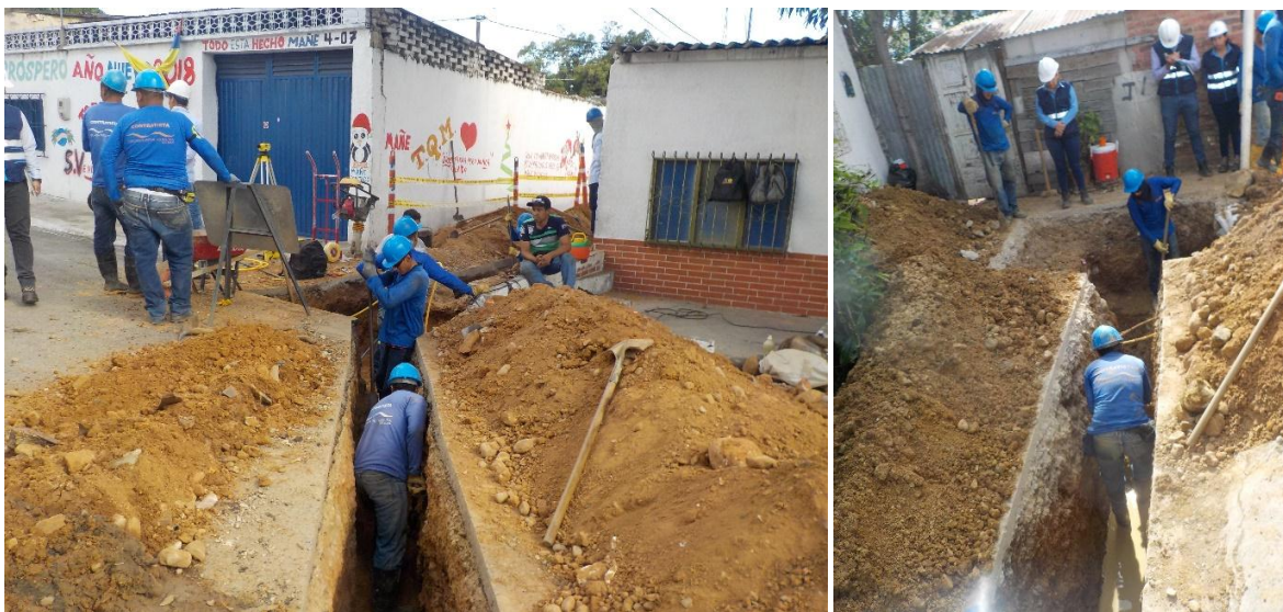
Figura 71. Reposición de alcantarillado en el barrio Bajo Pamplonita
